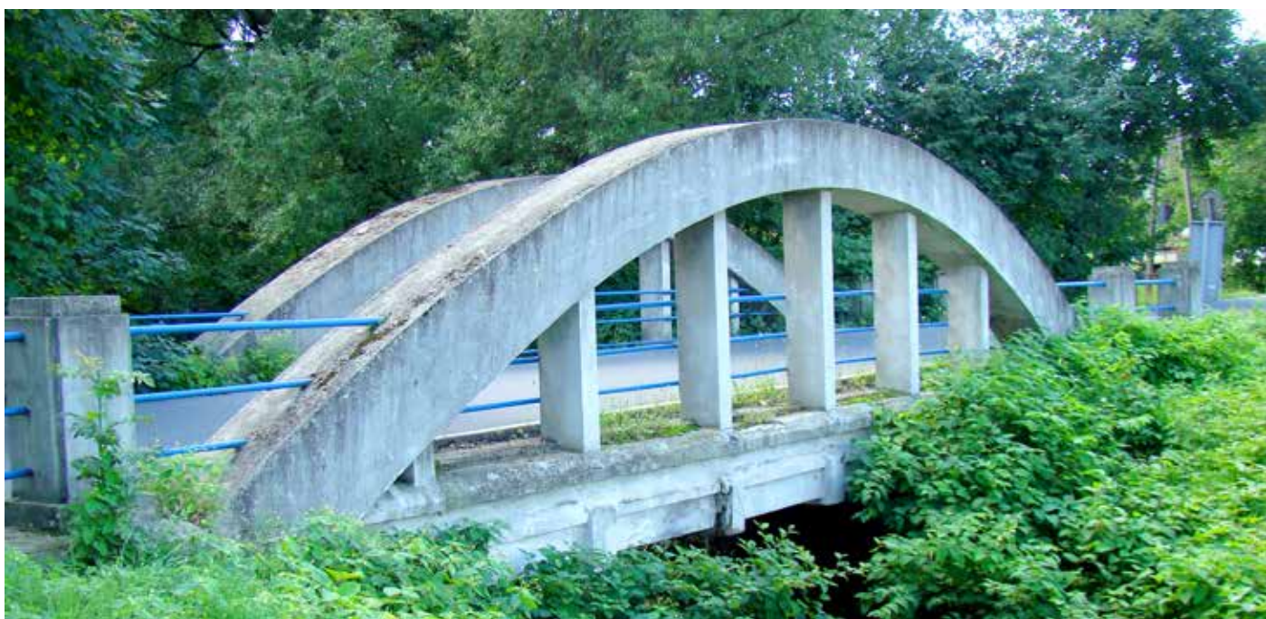
Żymowiec - most żelbetonowy z 1926.
