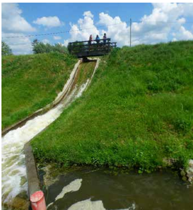
Kaskada rowu obiegowego pochylni Jelenie z kładką na ścieżce holowniczej, foto Stanisław Januszewski
