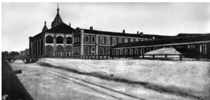
Budynek basenu doświadczalnego i laboratorium Dmitrija Mendelejewa (z prawej strony)
