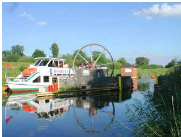
Statek kanałowy przy filarze kół zwrotnych dolnego stanowiska pochylni Całuny, foto Stanisław Januszewski
