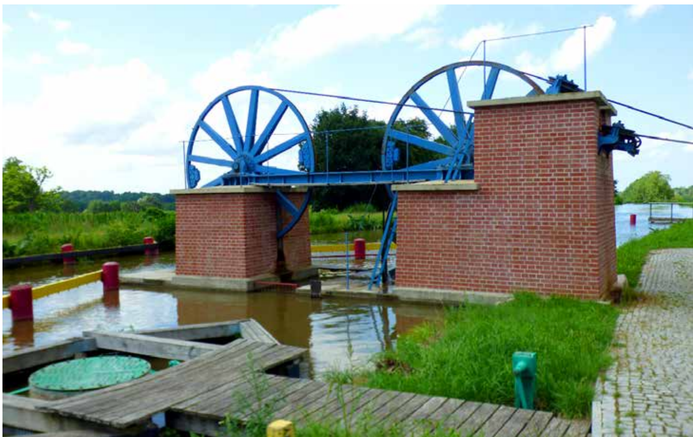
Filar kół linowych górnego stanowiska oraz maszynownia z kołem wodnym pochylni Kąty, przed filarem standardowe dla pochylni Kanału ujęcie wody do skrzyni koła wodnego, foto Stanisław Januszewski
