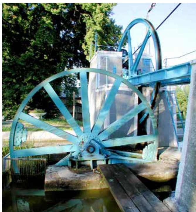
Jelenie. Filar i koła kierunkowe/zwrotne na górnym stanowisku pochylni, foto Stanisław Januszewski
