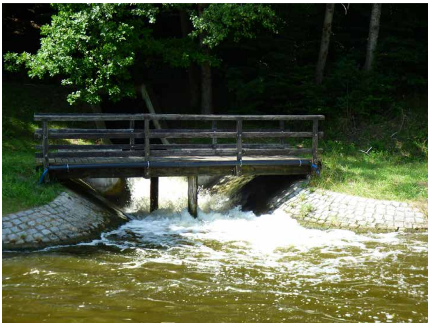
Ujście kanału obiegowego do kanału Elbląskiego na dolnym stanowisku pochylni Buczyniec, foto Stanisław Januszewski
