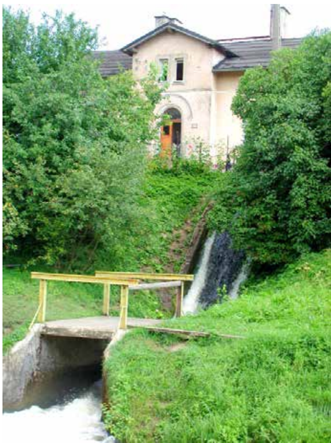
Bystrotok rowu obiegowego pochylni Kąty u wlotu do Kanału Elbląskiego, foto Stanisław Januszewski
