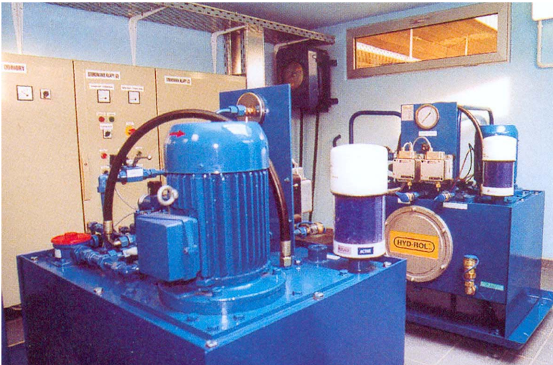
Nowoczesne zasilanie hydrauliczne jazu.
