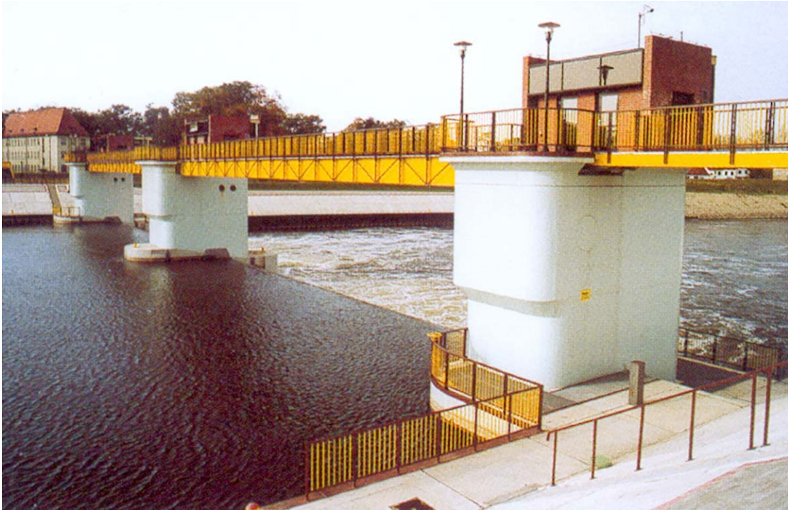
Widok na jaz klapowy na Starej Odrze od wody górnej – wraz z przepławką dla ryb i kładką komunikacyjną.
