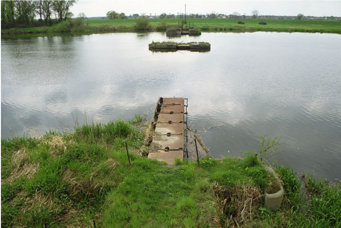
Widok na wyłączony z eksploatacji jaz koźłowo-iglicowy. Na pierwszym planie nie rozebrana oryginalna część konstrukcji jazu.
