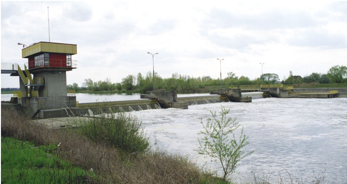
Jaz sektorowy Krapkowice od wody dolnej.
