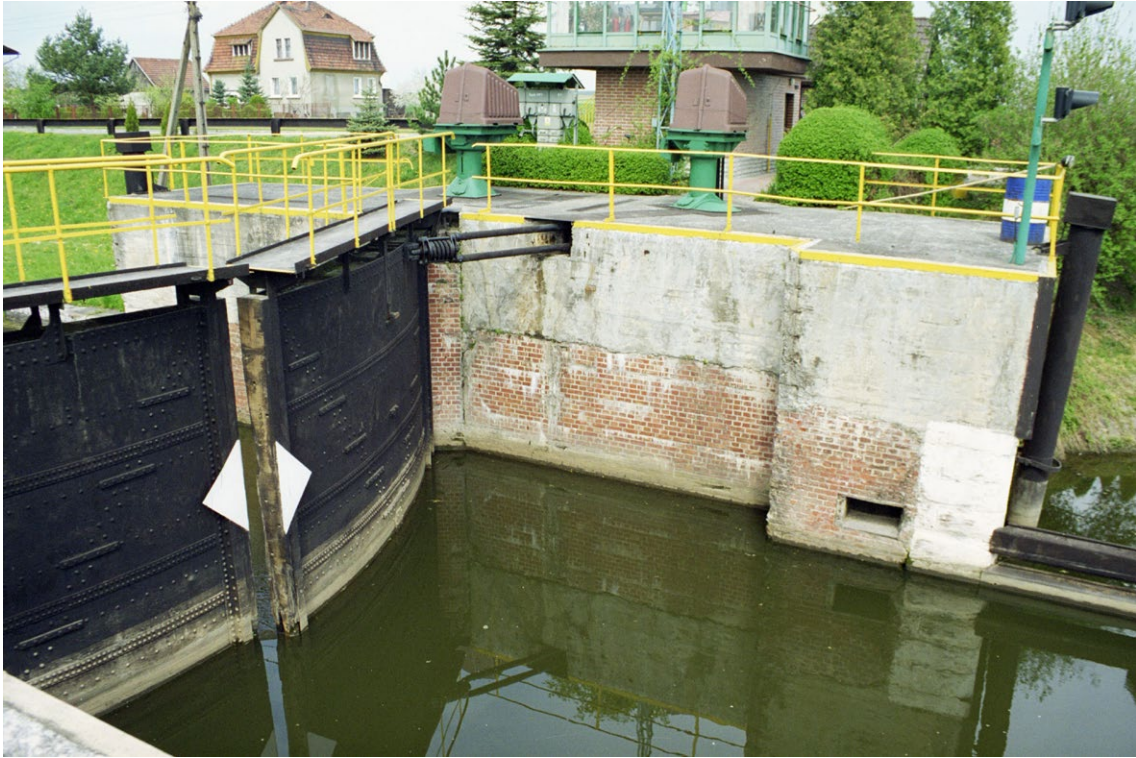
Wrota dolne śluzy pociągowej. Na drugim planie – zachowana zabudowa przystopniowa oraz fragment (typowej) sterówki z lat 70. XX w.
