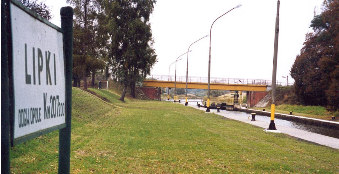
Widok na komorę i głowę dolną śluzy pociągowej i nowy most.
