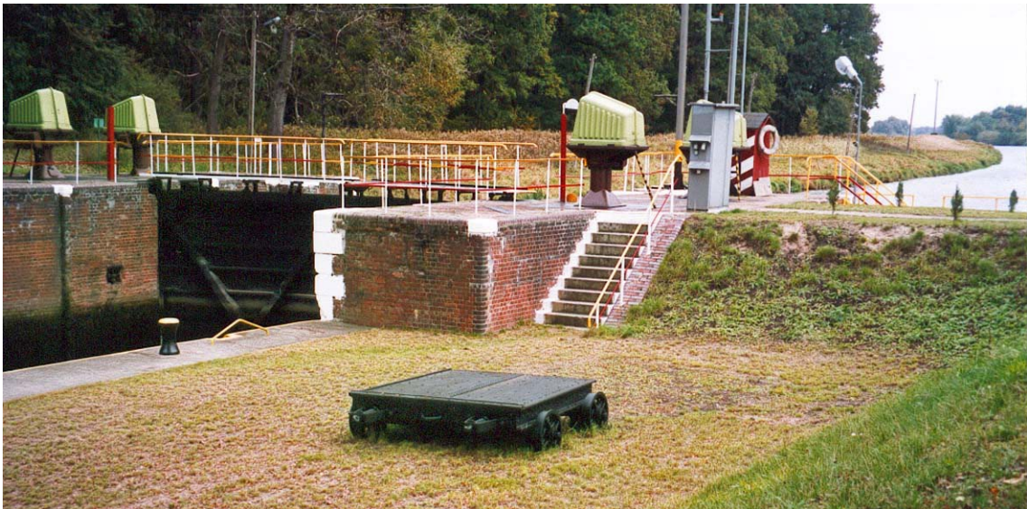
Głowa górna, wrota i awanport śluzy od strony komory. Na pierwszym planie wyeksponowana zasuwa zapasowa kanału obiegowego.
