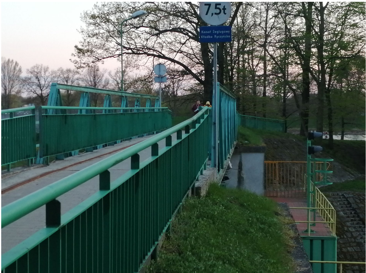
Konstrukcja mostu znad głowy dolnej śluzy Lipki zamontowana na głowie dolnej śluzy Bartoszowice.
