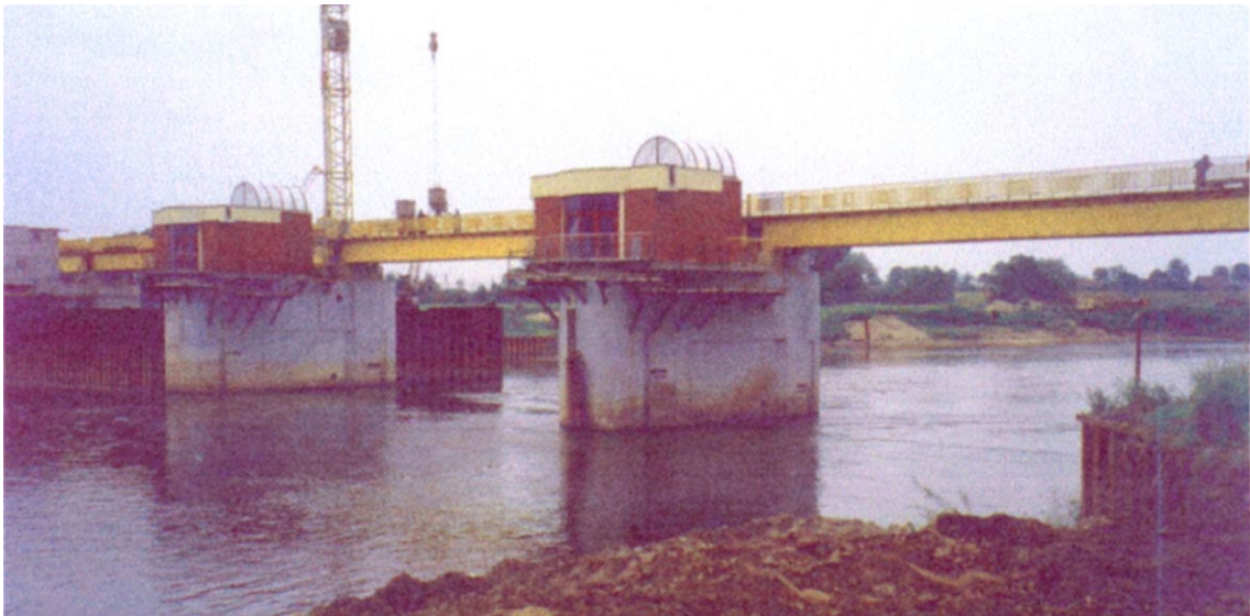
Jaz klapowy Lipki w trakcie budowy trzeciego przęsła.
