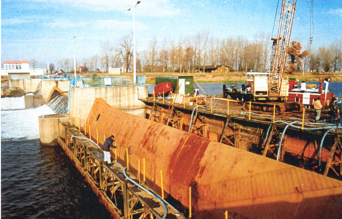
Remont powodziowy lewego sektora jazu. Widoczne zamknięcia remontowe od wody górnej i dolnej.
