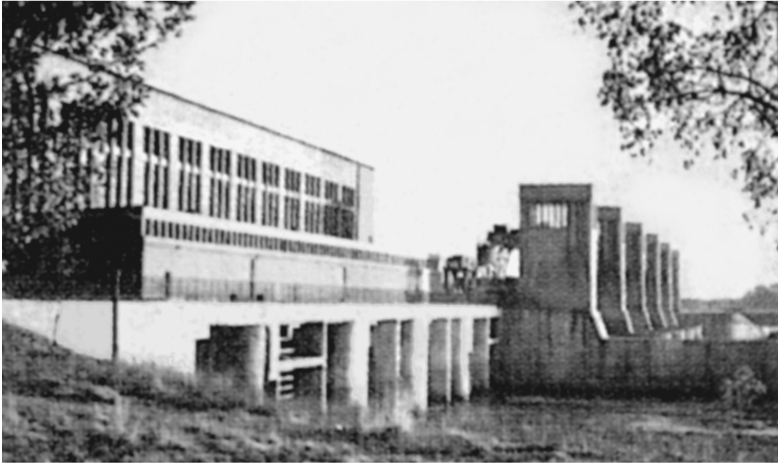
Elektrownia wodna „Wały Śląskie” od dolnej wody.
