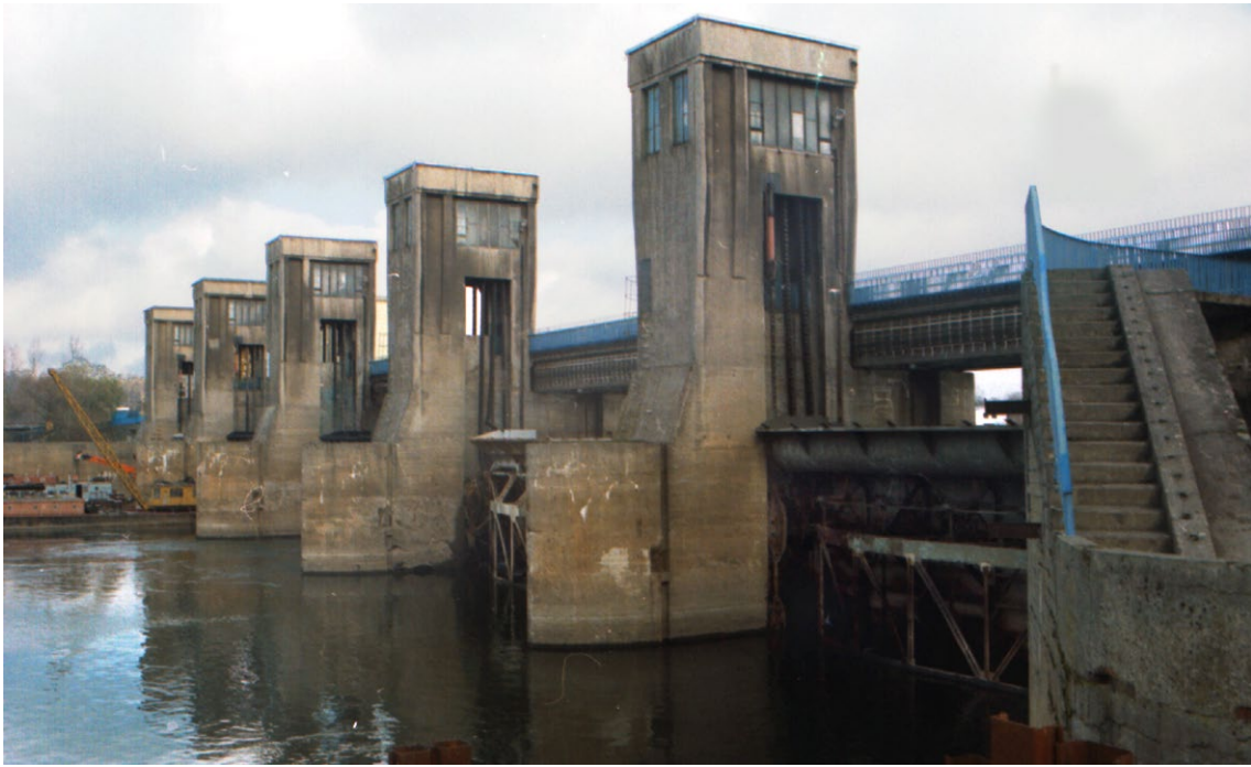
Jaz zasuwowo – kłapowy Brzeg Dolny od strony wody dolnej.
