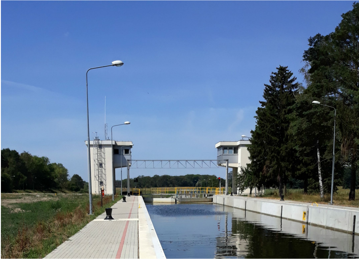
Unowocześniona śluza po remoncie.
