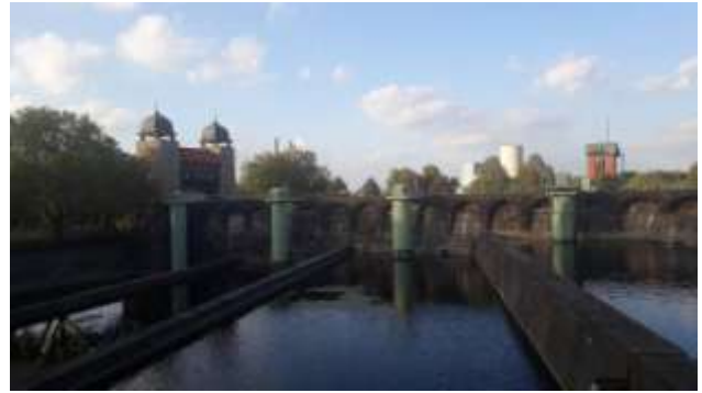
Śluza z 1914 r. w kompleksie Heinrichenburg w Waltrop, 2019 r.
