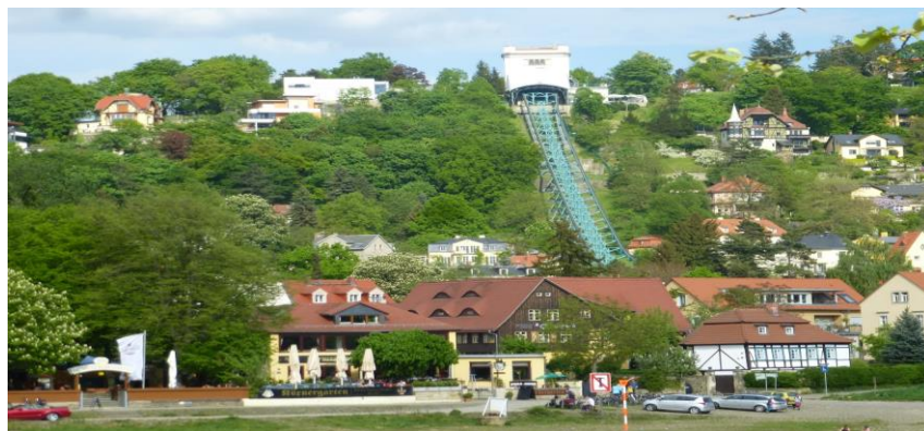
Stacja górna w Oberloschwitz i konstrukcja jezdnia kolejki widoczne z lewego brzegu Łaby
