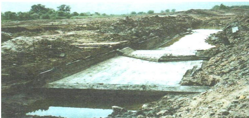
Drewniane dno śluzy z tego samego okresu historycznego, co śluza Piaskowa, odkryte przy budowie nowego stopnia wodnego Malczyce.
