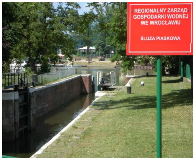
Murowana Śluza Piaskowa z otwartymi wrotami do stałego przepływu wody, po remoncie w latach 90-tych XX w.
