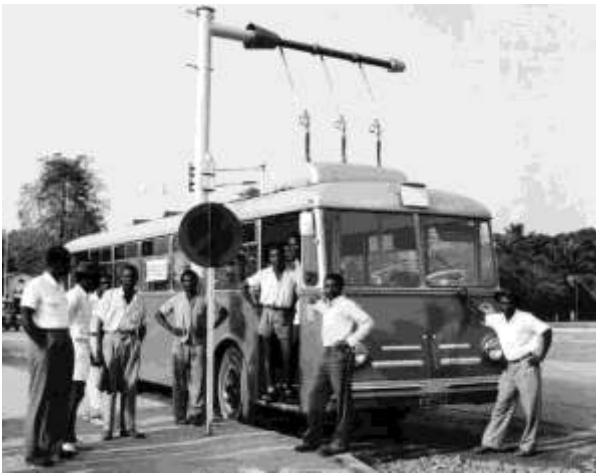
Żyrobus w czasie uzupełniania zapasu energii na przystanku końcowym w Leopoldville
