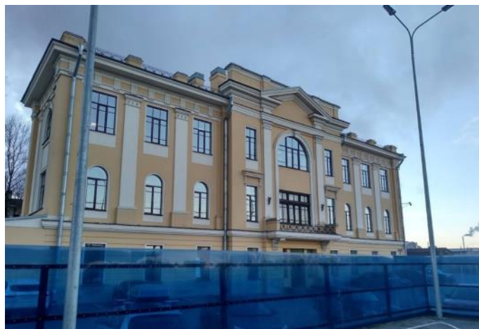
Fot. 2 Gmach Główny Szkoły — stan budynku w grudniu 2021 r., foto Autor
