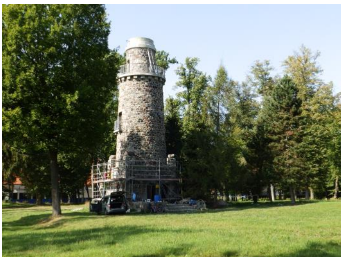
Fot. 4. Renowacja wieży – stan na 24.09.2020 r.
