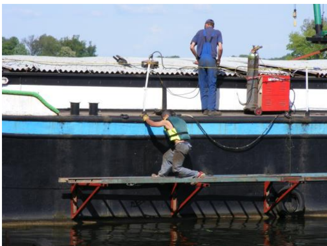
Fot. 8. Prace remontowe 2020
