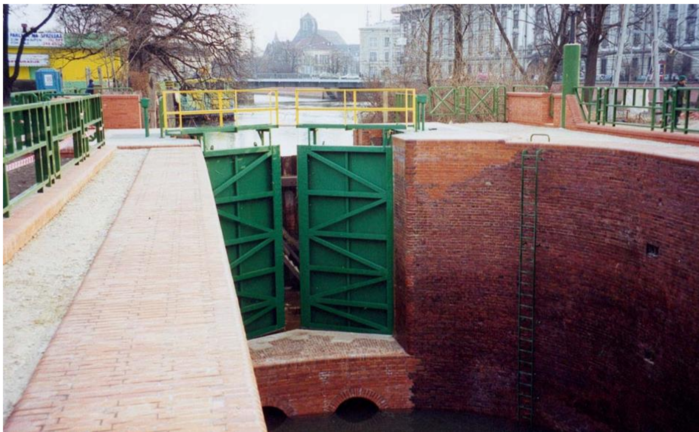
Śluza Mieszcańska – widok górnej głowy z brzegu prawego w końcówce remontu, zablokowana jeszcze stalowym zamknięciem remontowym od wody górnej. Fot.: Ryszard Majewicz.
