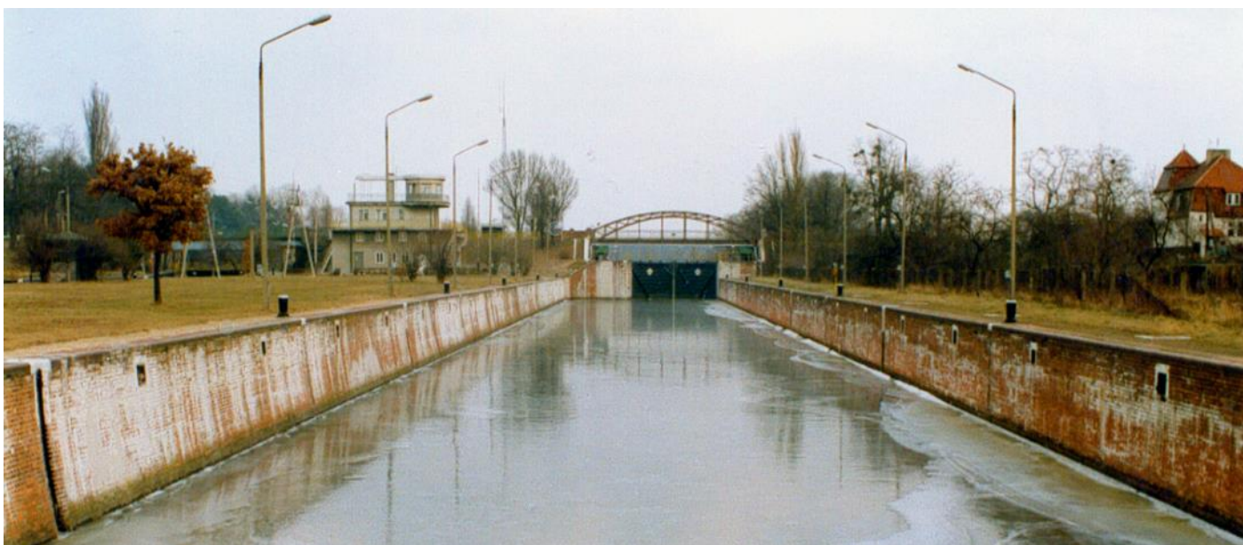
Komora śluzy ceglanej. Widok na głowę górną, most nad śluzą i sterownię od dolnej wody (przed modernizacją).
