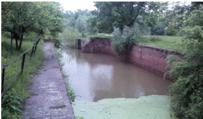
Komora śluzy z przestawionymi głowami w Oławie – widok z brzegu lewego od górnej głowy. Fot.: Ryszard Majewicz.
