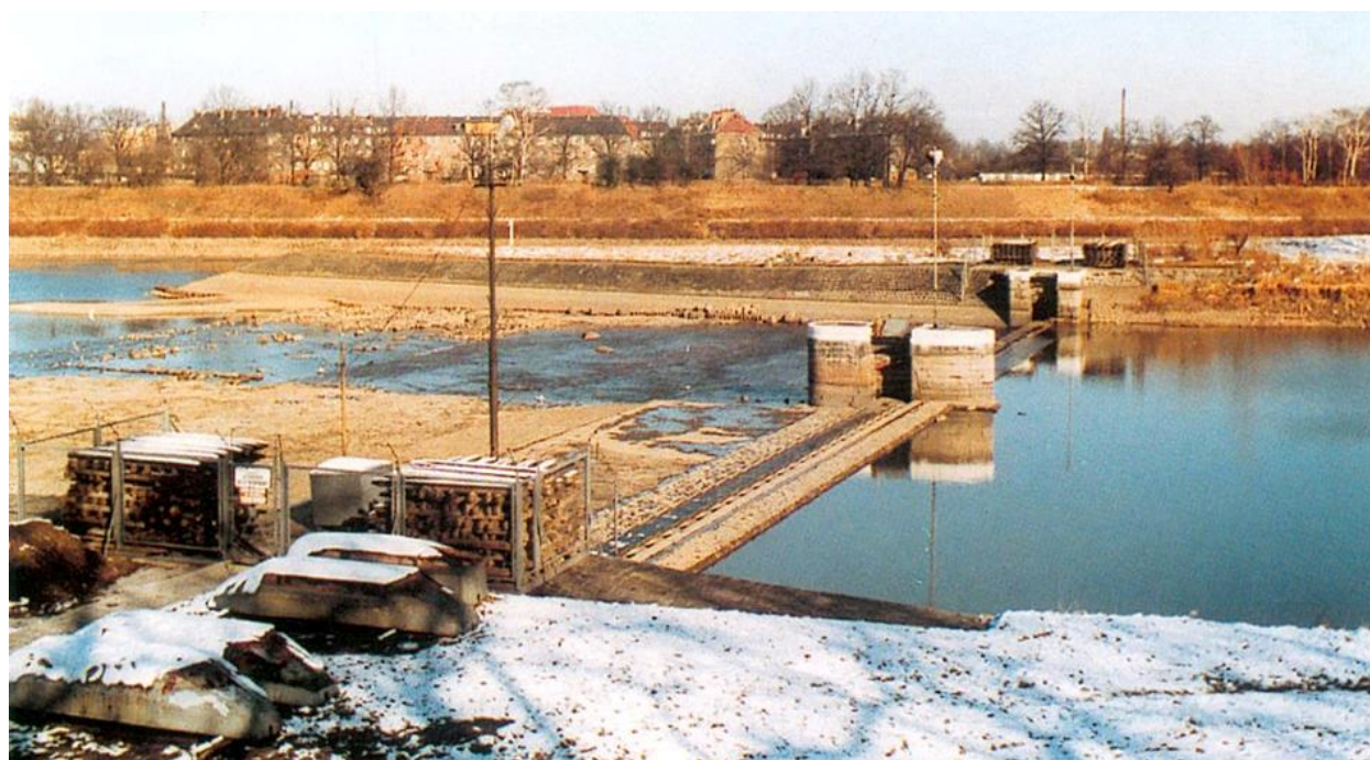
Jaz koźłowo-iglicowy Psie Pole, położony w dniu pod osłoną progu stałego jazu, z rozmontowanymi elementami złożonymi na brzegu oraz (osłoniętą metalową skrzynią) wciągarką (windą) do stawiania (i kładzenia) koźłów jazowych. Wciągarkę tego typu można obejrzeć na stopniu wodnym Bartoszowice, przechodząc obok terenów zaplecza technicznego RZGW we Wrocławiu.
