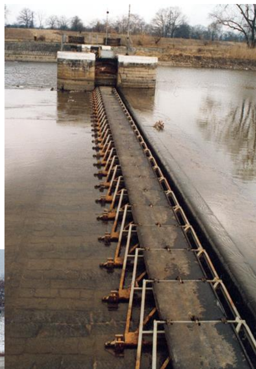
Kozły i kładka złożone w progu lewego przęsła jazu Psie Pole.
