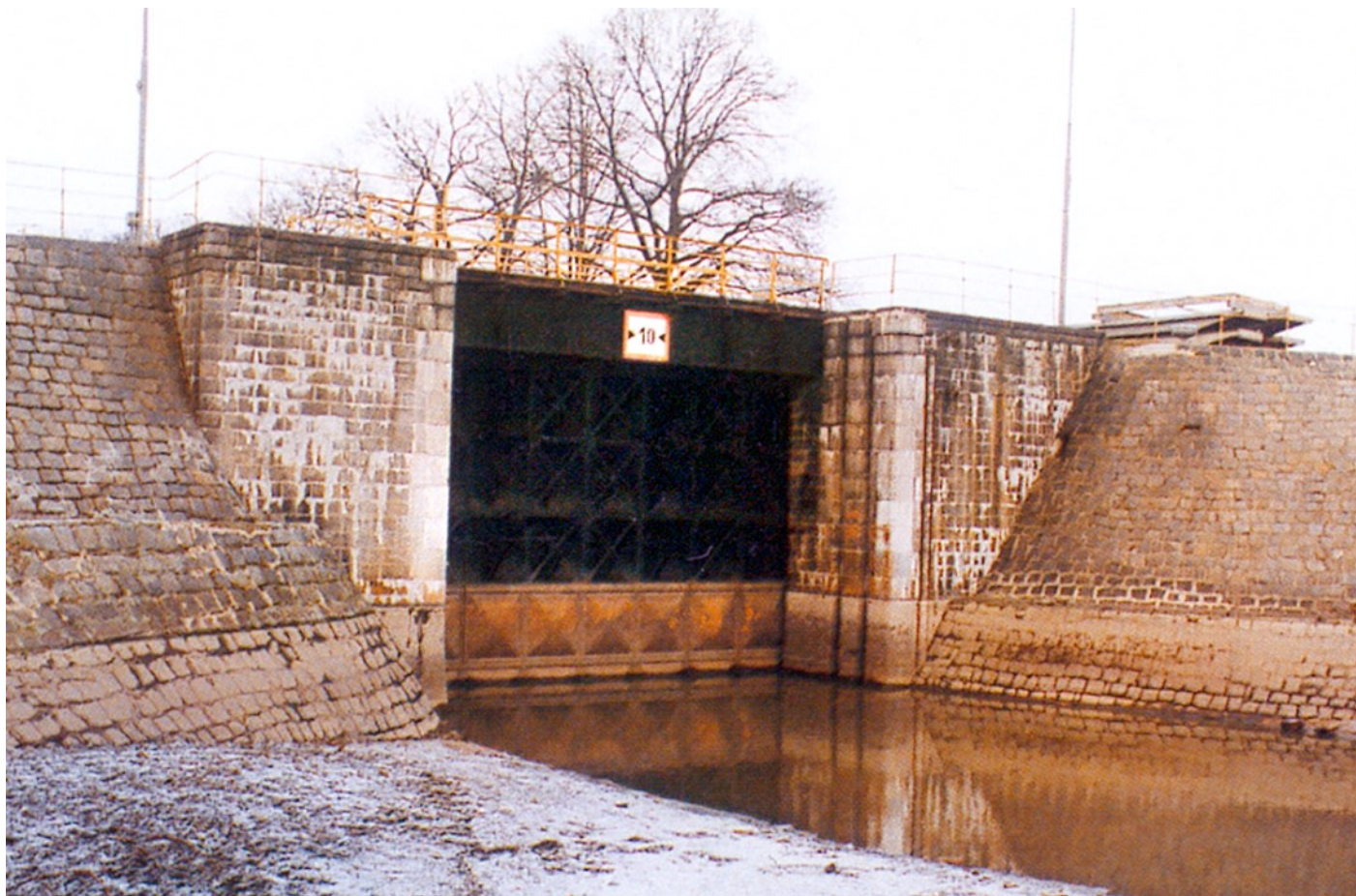
Zamknięta brama przeciwpowodziowa z mostem od górnej wody (przy położonym jazie Psie Pole)
