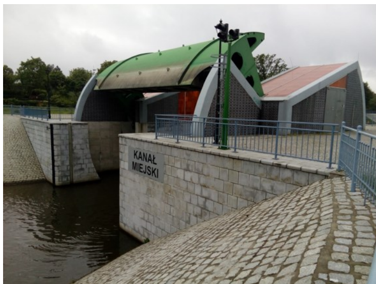
Nowa konstrukcja na Kanale Miejskim – wzorowana na zamknięciu górnej głowy śluzy Różanka na kanale Różanka, na Wrocławskim Węźle Wodnym
