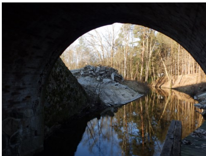
Tunel i rozebrany most – 13.01.2018 r. Fot. R. Kowalski
