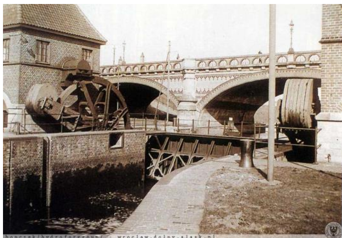
Głowa górna śluzy Różanka z zamknięciem segmentowym – 1916 r.
