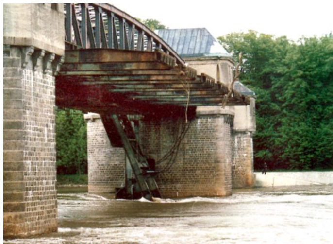
Jaz segmentowo – zasuwowy Rędzin podczas podnoszenia odrwi (z podniesionymi zasuwami) pod mostem jazowym nad przęsłem środkowym.
