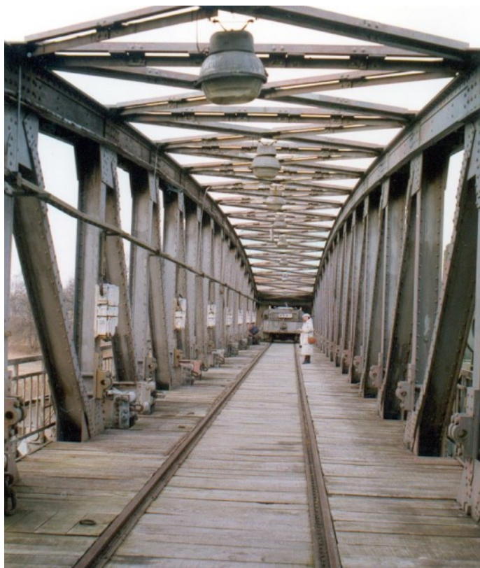
Jaz segmentowo – zasuwowy Rędzin. Widok mostu z torami dla wciągarek wózkowych oraz jednej z dwóch wciągarek.
