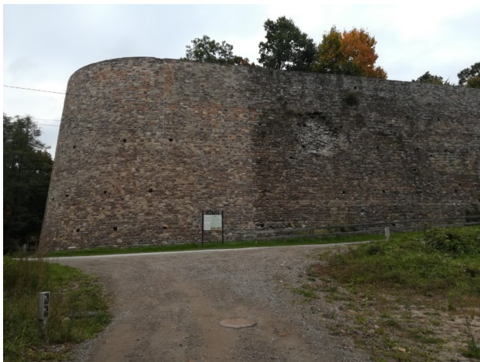
Dobrze zachowany mur oporowy
