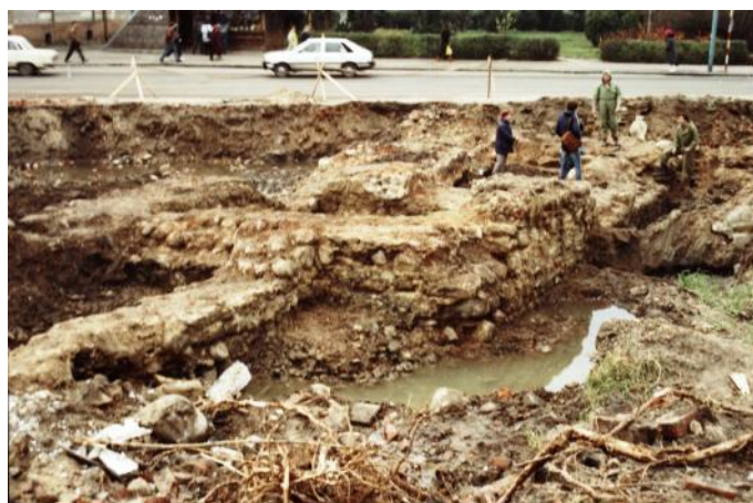
Wykopiska na placu budowy Banku PKO – 1992 r.
