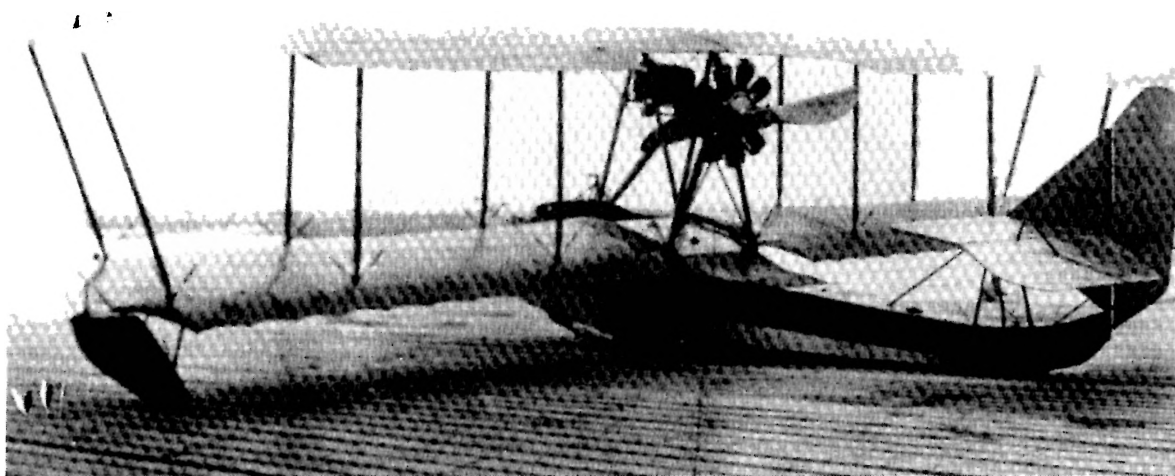
Łódź latająca M-9 Dmitrija P. Grigorowicza budowana w zakładach PRTW Siergieja S. Szczetinina pod kierunkiem Witolda Jarkowskiego
