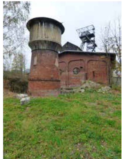
Wodociągowa wieża ciśnień
