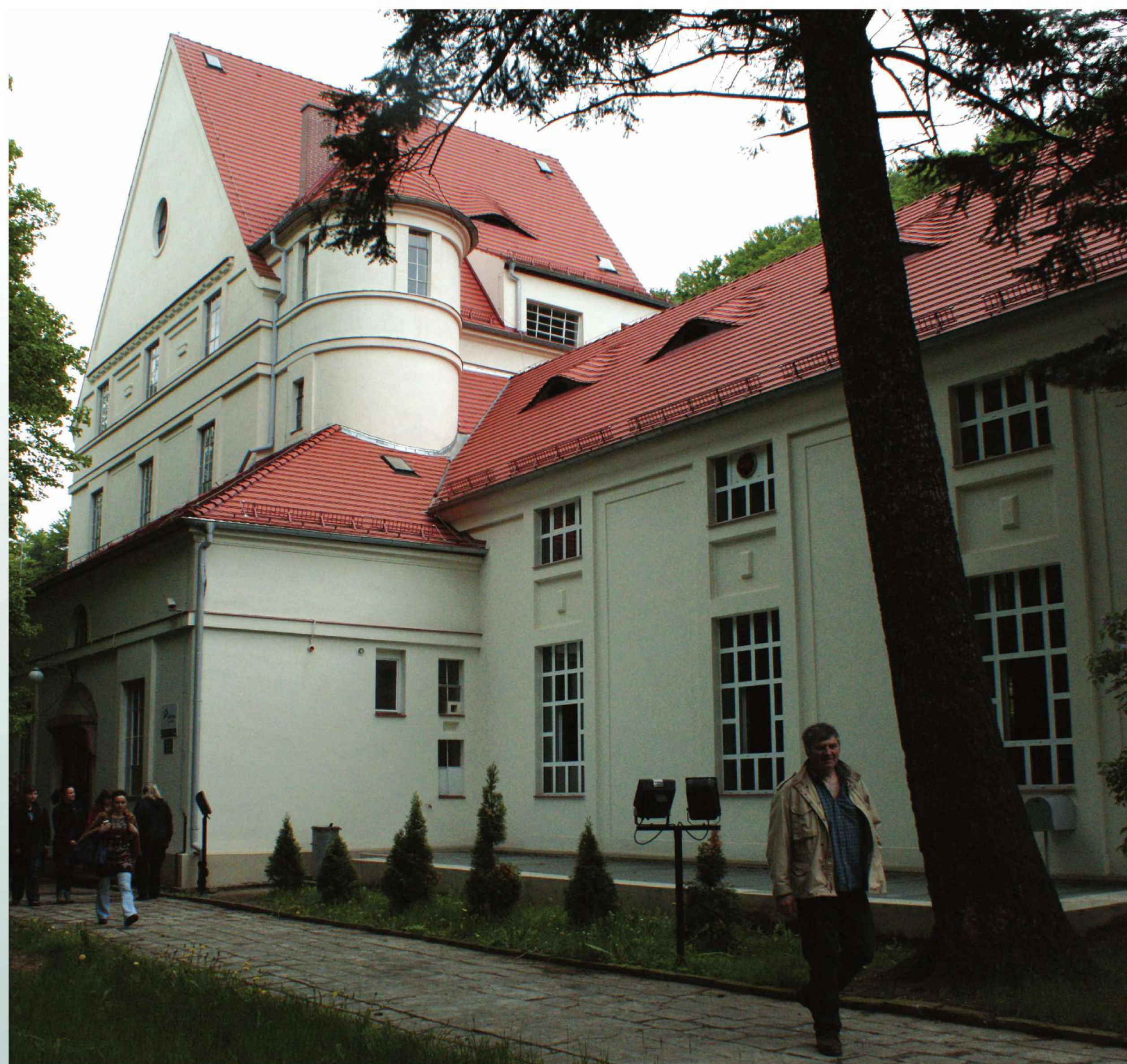
Elektrownia wodna 1912 - 1916 r.
