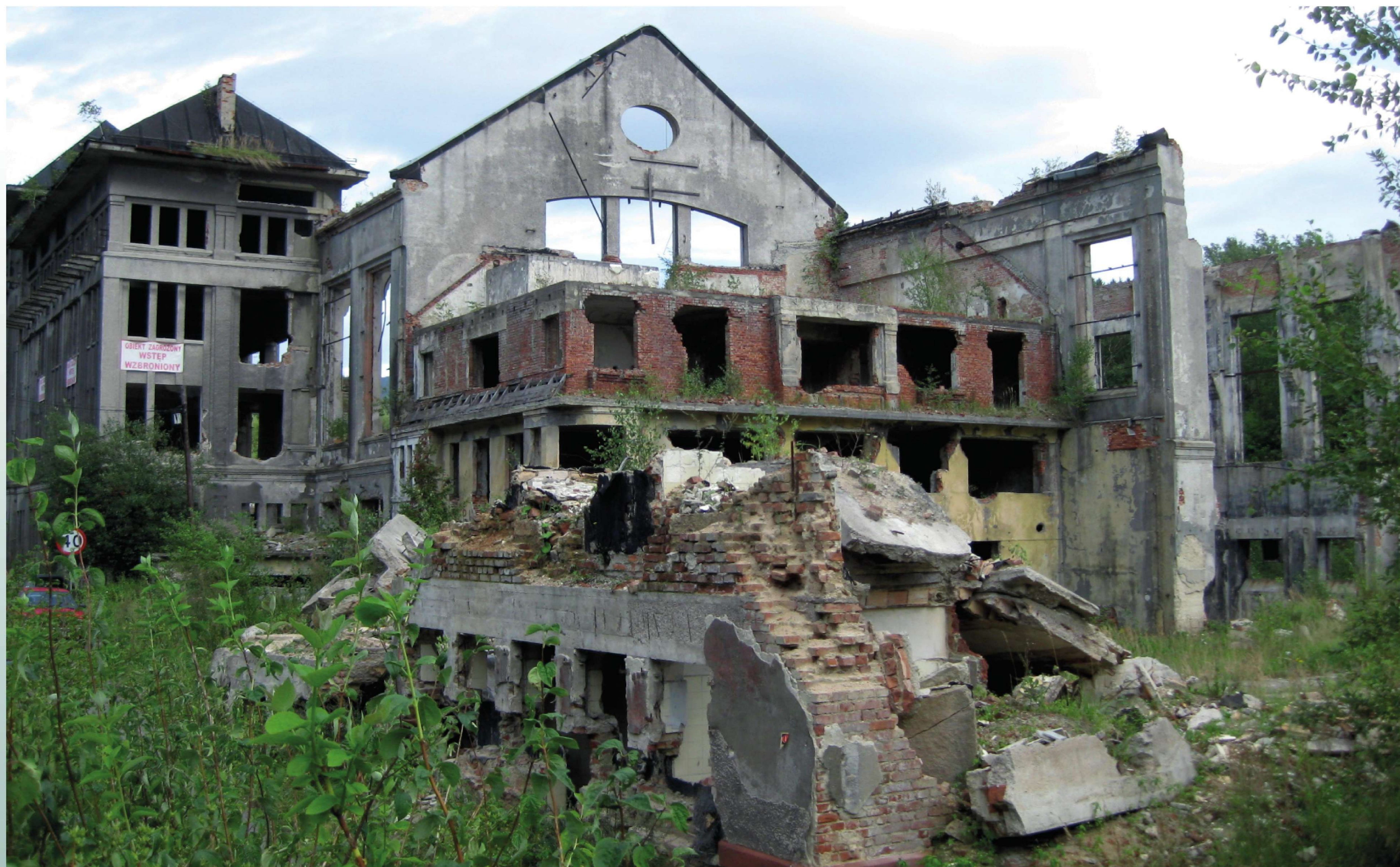
Ludwikowice - relikw elektrowni cieplnej Ludwikowo 1912 r.
