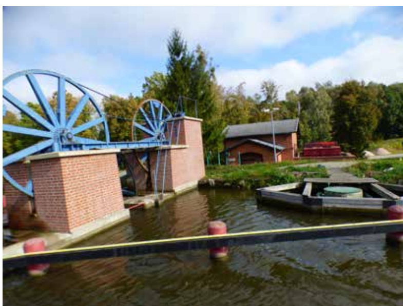
Filar kół linowych i maszynownia pochylni Kąty.
