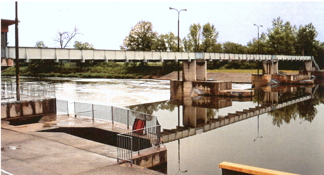
Widok jazu od strony wody górnej.
