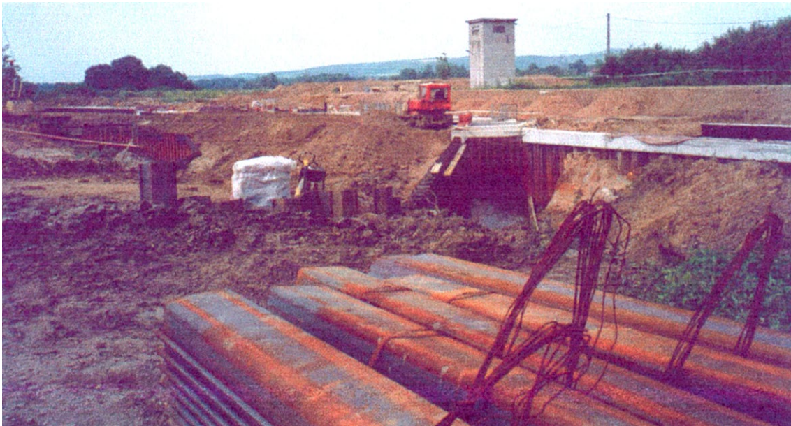
Widok placu budowy nowej elektrowni wodnej.
