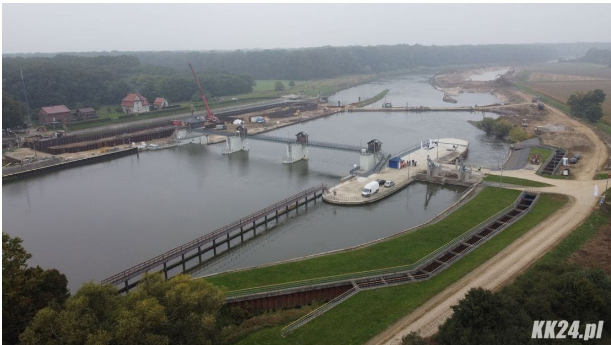
Sytuacja stopnia wodnego Januszkowice po modernizacji jazu sektorowego na kłapowy. Źródło:
