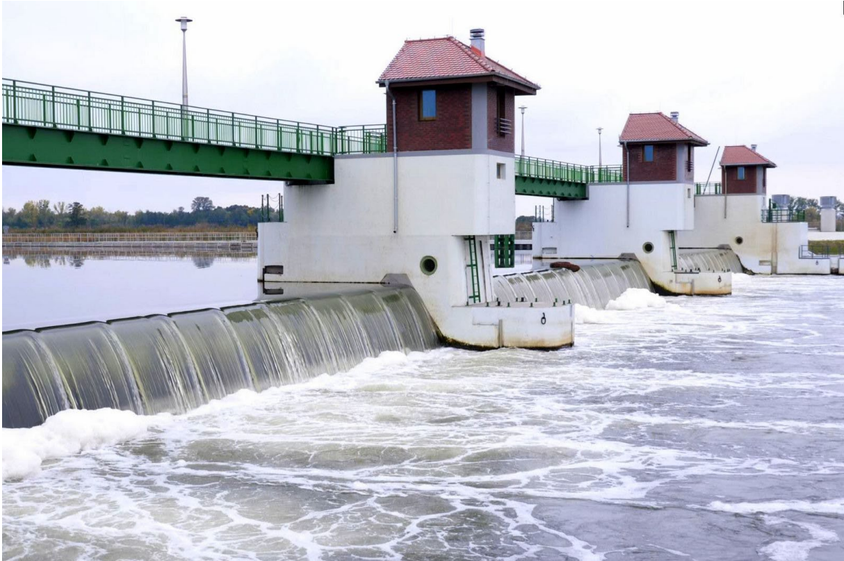
Jaz klapowy Januszkowice od dolnej wody.
