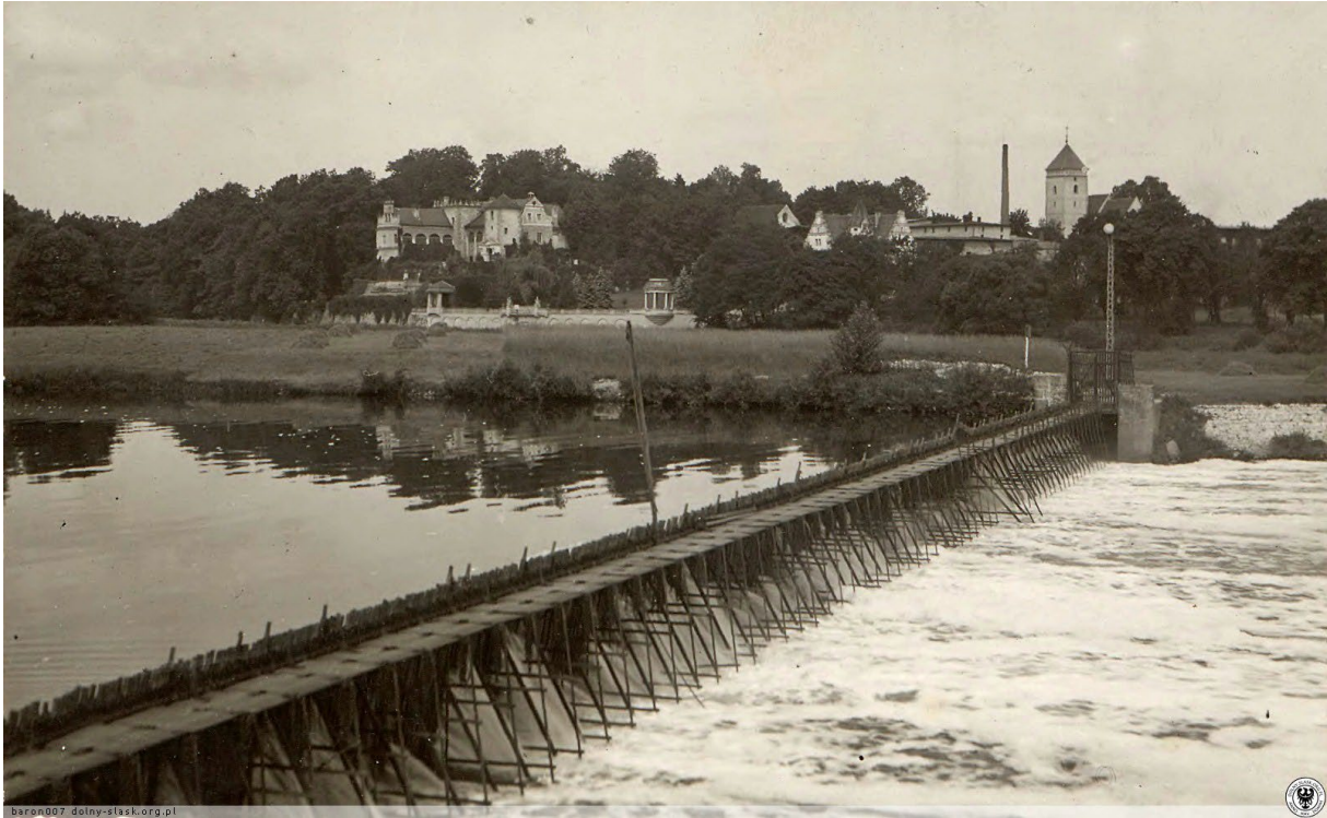
Jaz kozłowo-iglicowy od dolnej wody w latach 1920-1935.
