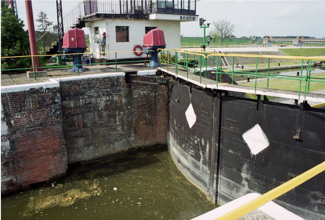
Wrota górne śluzy pociągowej. Dalej widoczne: sterówka, komora śluzy małej oraz jaz kłapowy z kładką.
