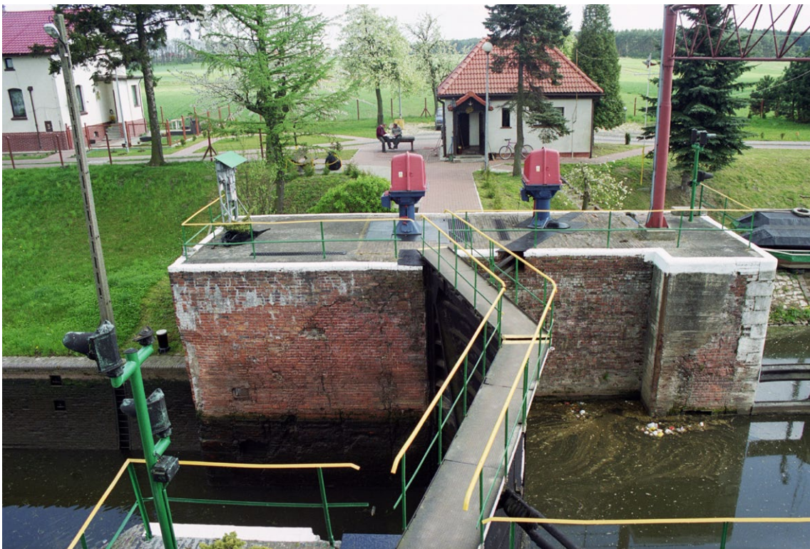
Widok ze sterówki na głowę górną śluzy pociągowej. Kładka komunikacyjna na wrotach prowadząca do zabudowy przystopniowej (w głębi).
