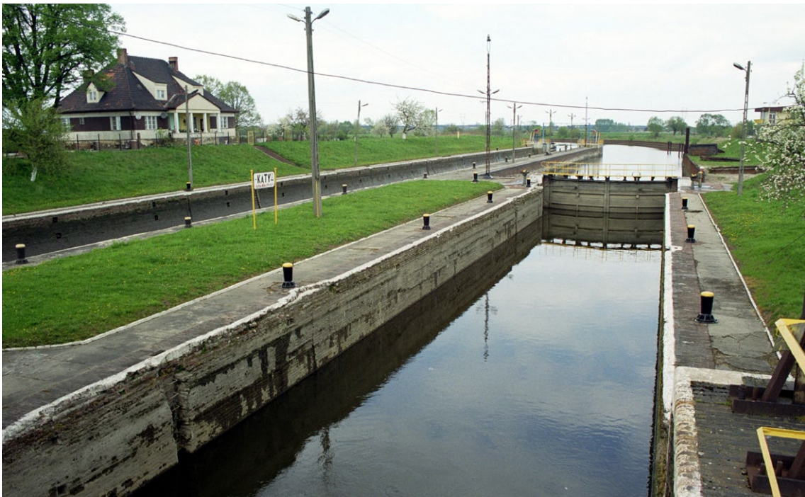
Widok komór śluz małej i dużej w kierunku wrót dolnych.
