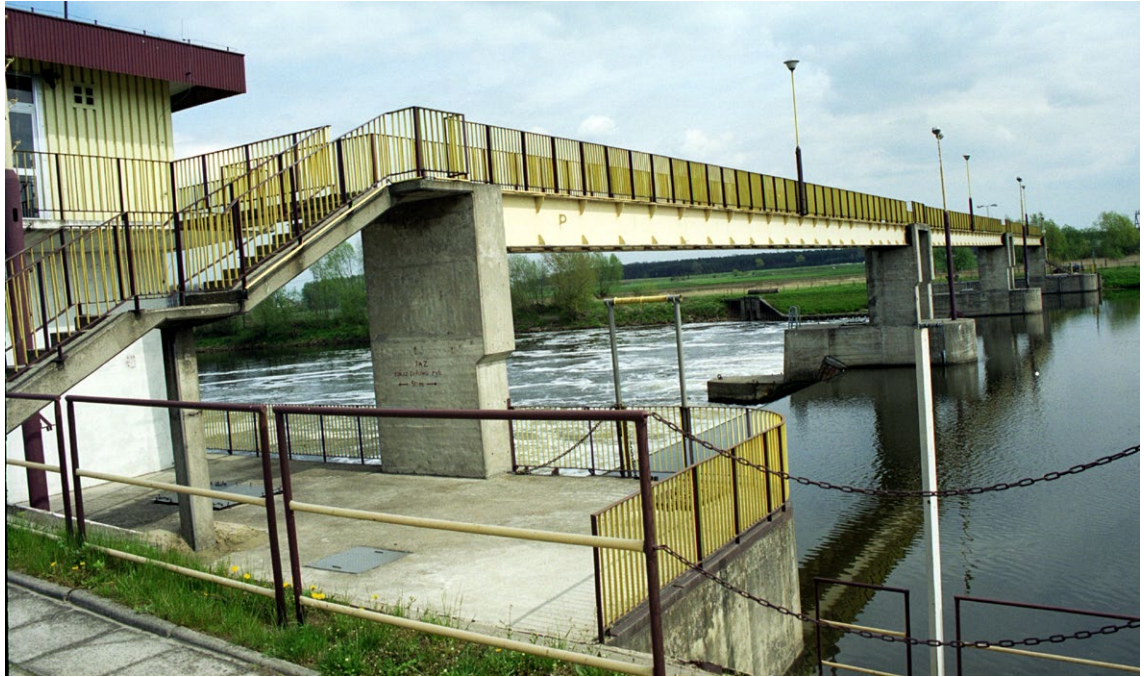
Jaz sektorowy Kąty ze sterownią i kładką komunikacyjną.
