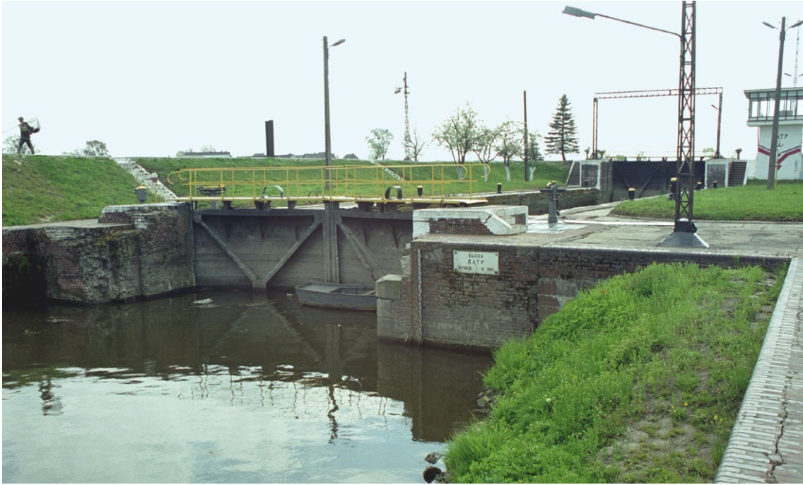
Widok śluzy małej z awanportu dolnego.
