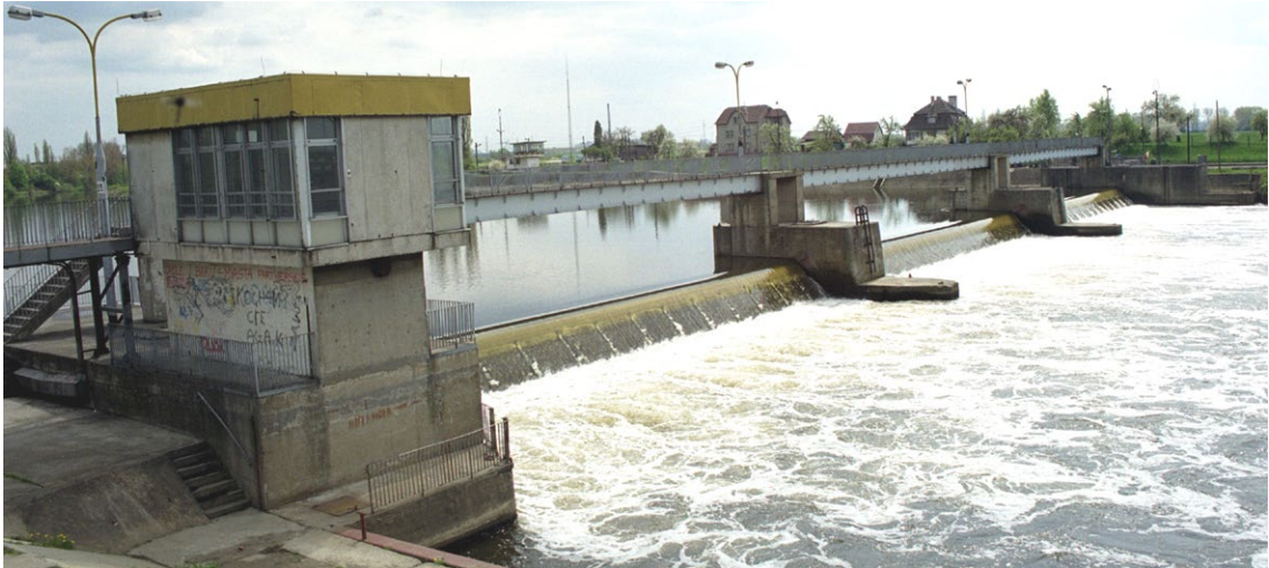
Jaz sektorowy Groszowice od wody dolnej.
