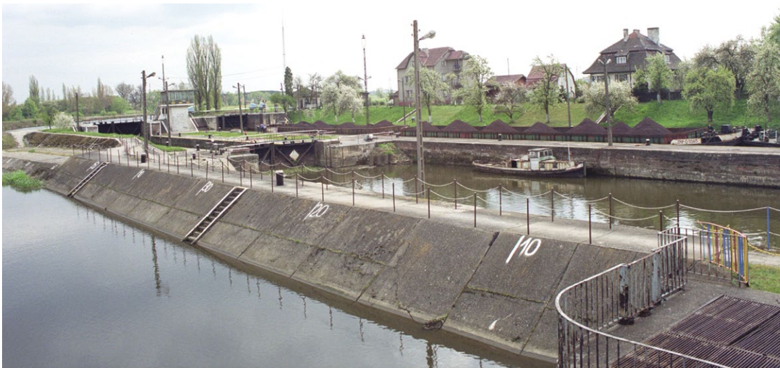
Tama rozdzielająca awanport dolny śluzy małej od stanowiska górnego jazu. W prawym dolnym rogu – fragment przepławki dla ryb przy lewym przyczółku jazu. W głębi – zmodernizowana zabudowa przystopniowa.
