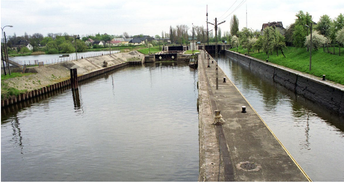
Awanport dolny śluzy małej i komora śluzy dużej. W głębi – zabudowa przystopniowa.
