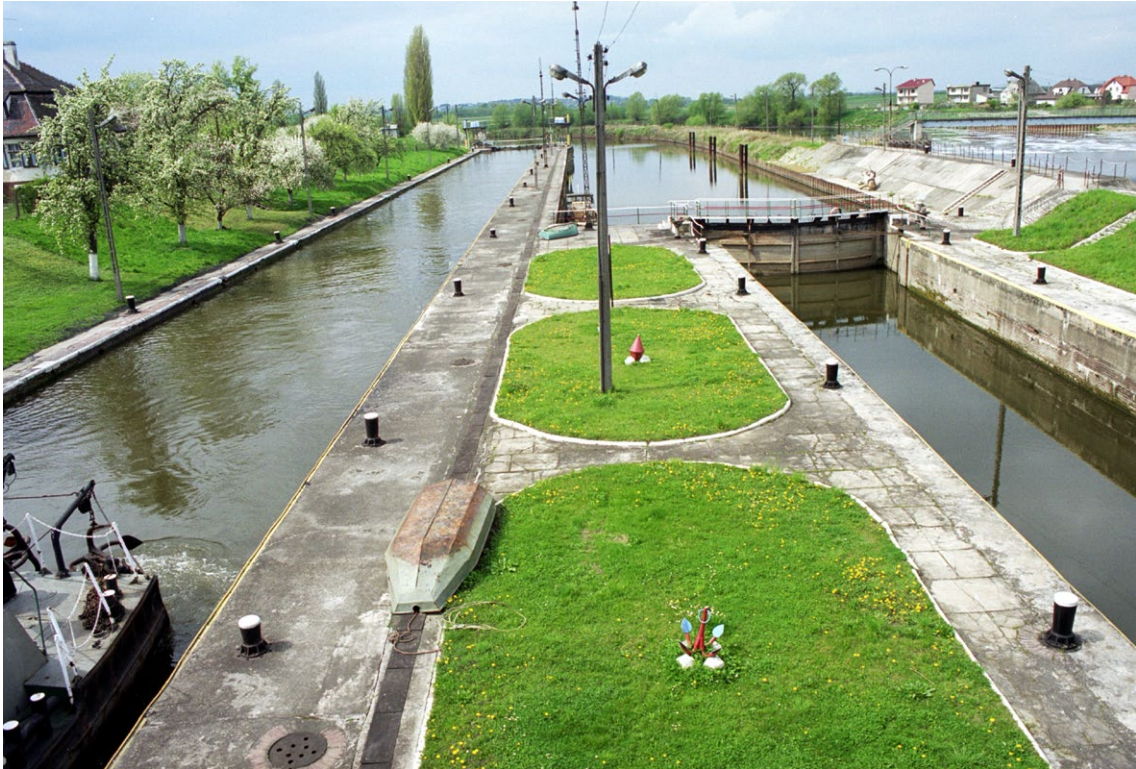
Widok stopnia wodnego Gorszowice ze sterowni śluz w kierunku wody dolnej.
