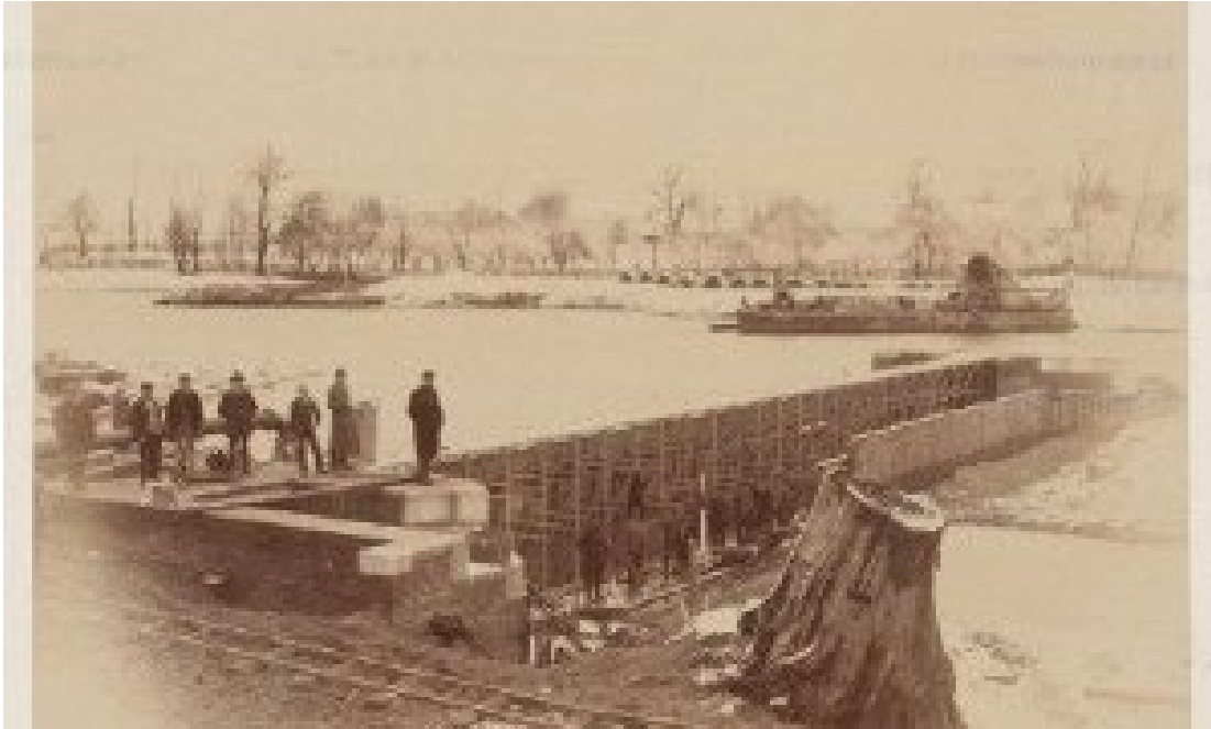
Budowa jazu w Groszowicach. Zdjęcie z końca XIX wieku.
