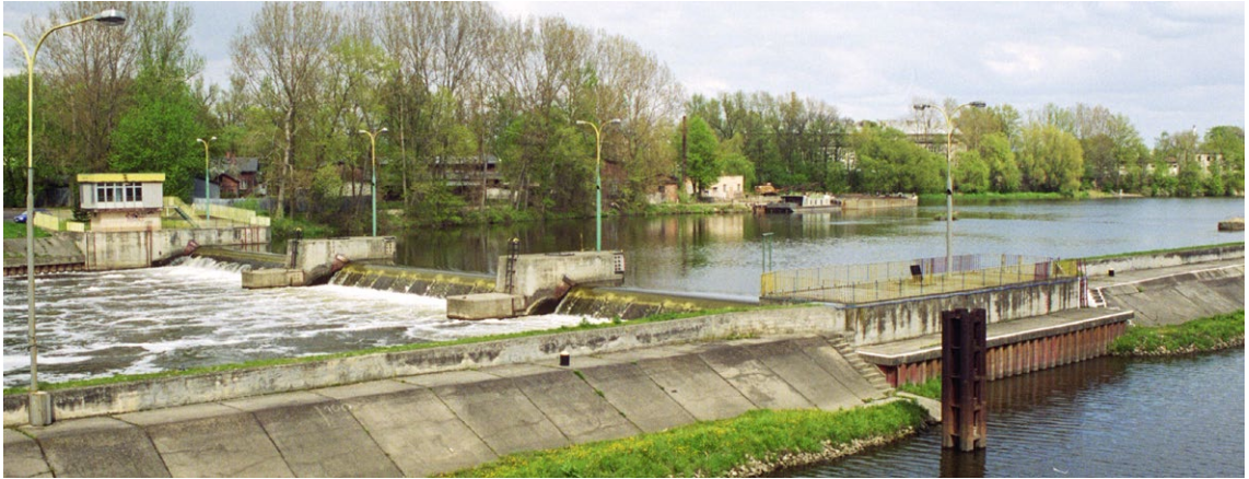
Jaz sektorowy Opole. Powyżej jazu - widoczny filar nurtowy nieczynnego jazu koźłowo-iglicowego.
