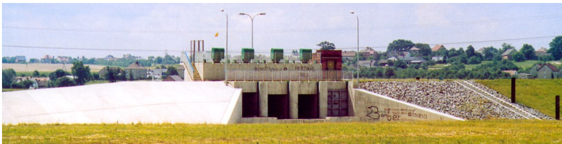
Przepust wałowy (przewał) dla wód powodziowych między projektowanym polderem Winów a kanałem ulgi w Opolu.
