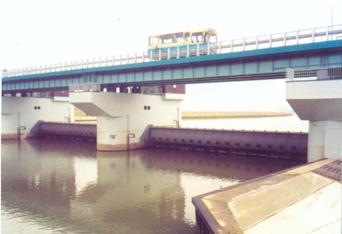
Jaz kłapowy na kanale ulgi z mostem drogowym.
