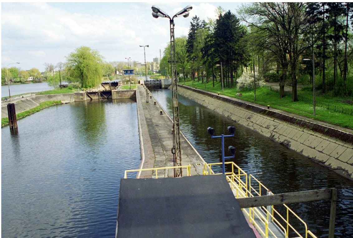
Awanport dolny śluzy małej i komora śluzy dużej.
