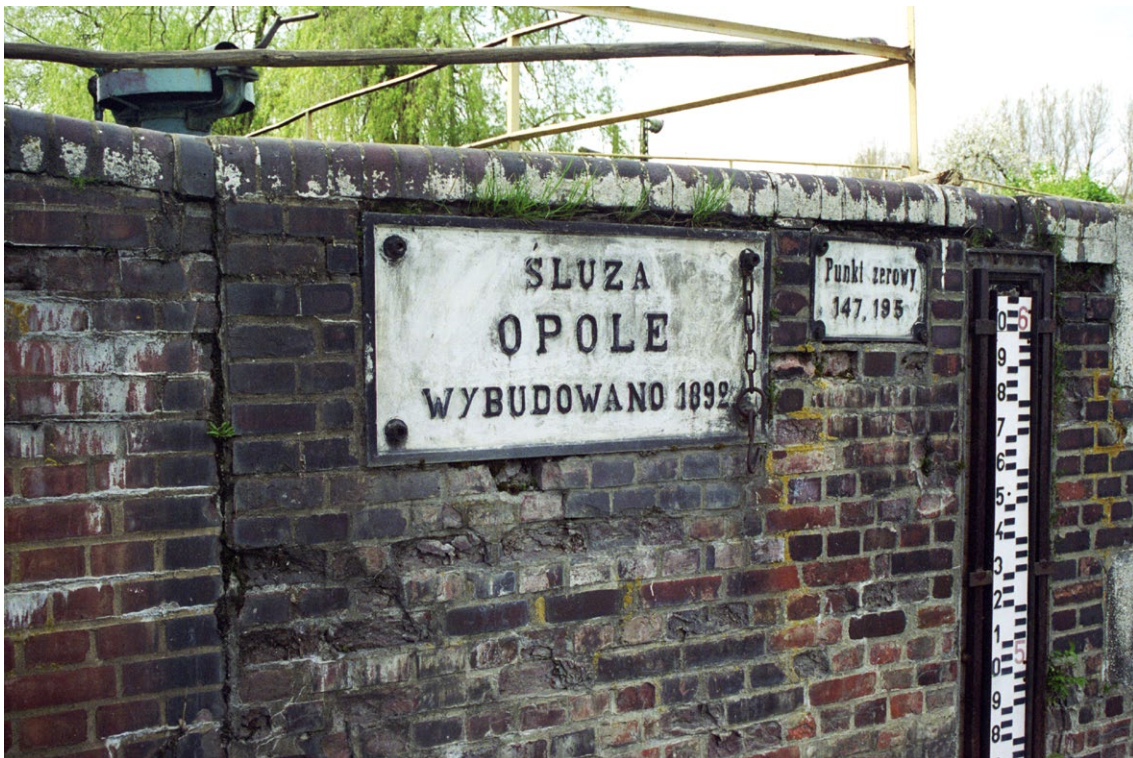
Fragment głowy śluzy małej Opole z łatą i punktem zerowym wodowskazu.
