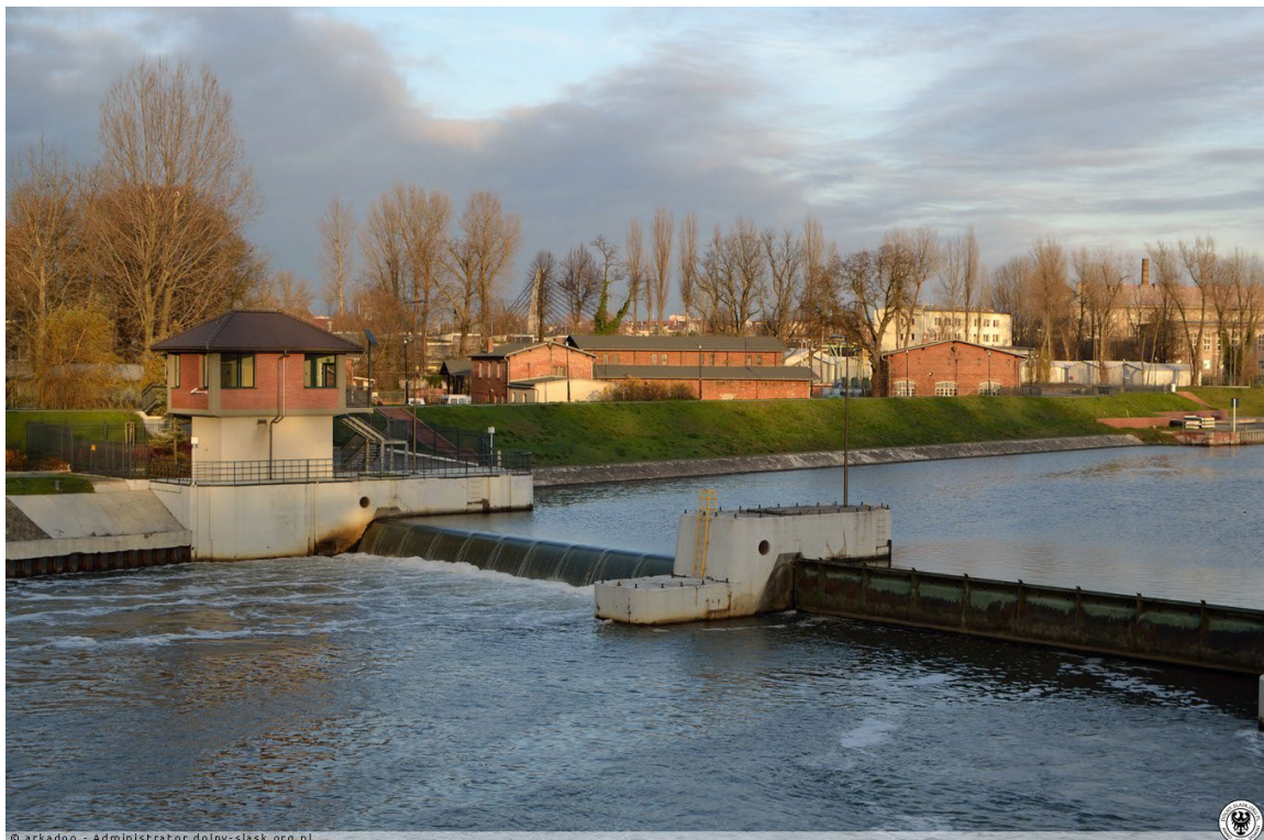
Sterówka i kłapy (prawa i część środkowej - podniesionej) jazu Opole.
