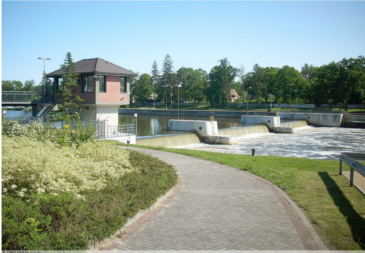
Jaz kłapowy Opole – widok z prawego brzegu od dolnej wody.
