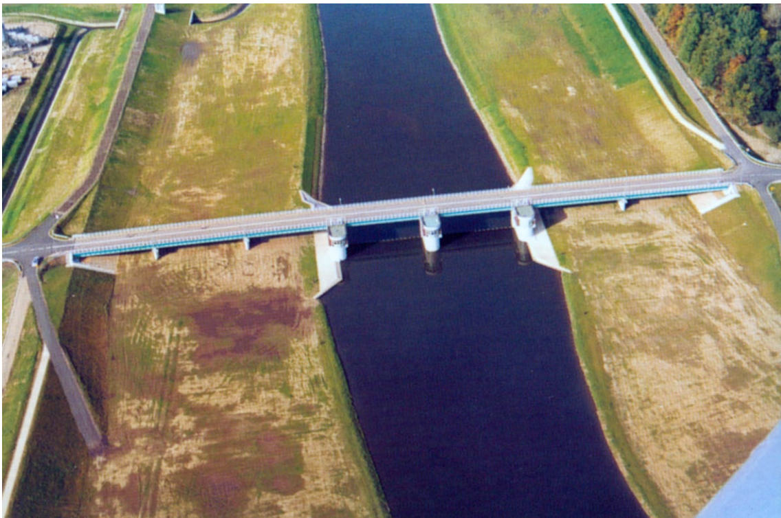
Kanał ulgi w Opolu z jazem klapowym i mostem drogowym.
