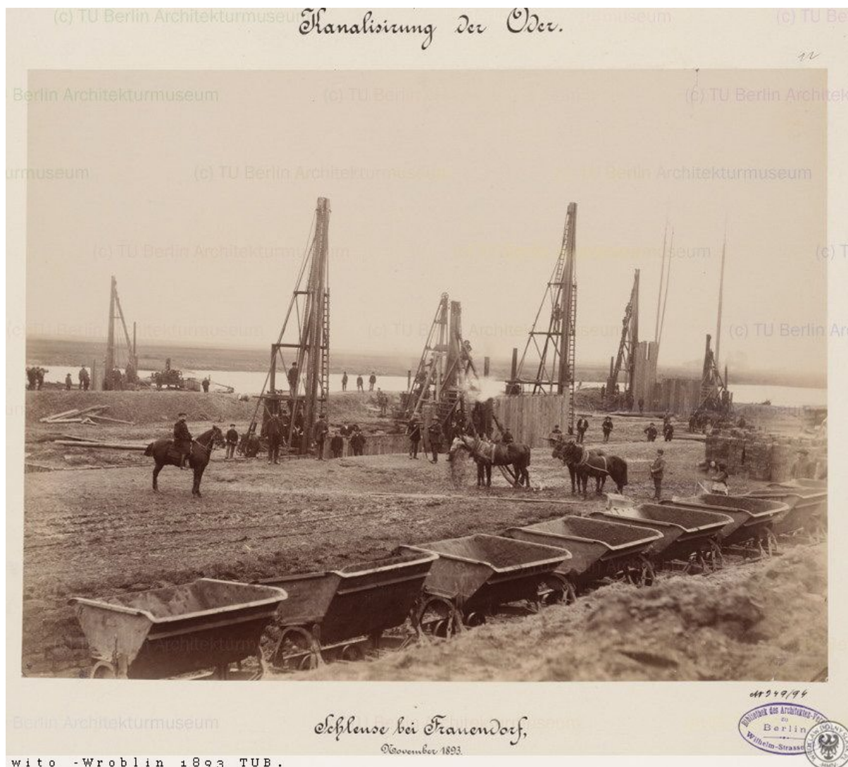
Widok placu budowy komory śluzy małej, listopad 1893 r.
