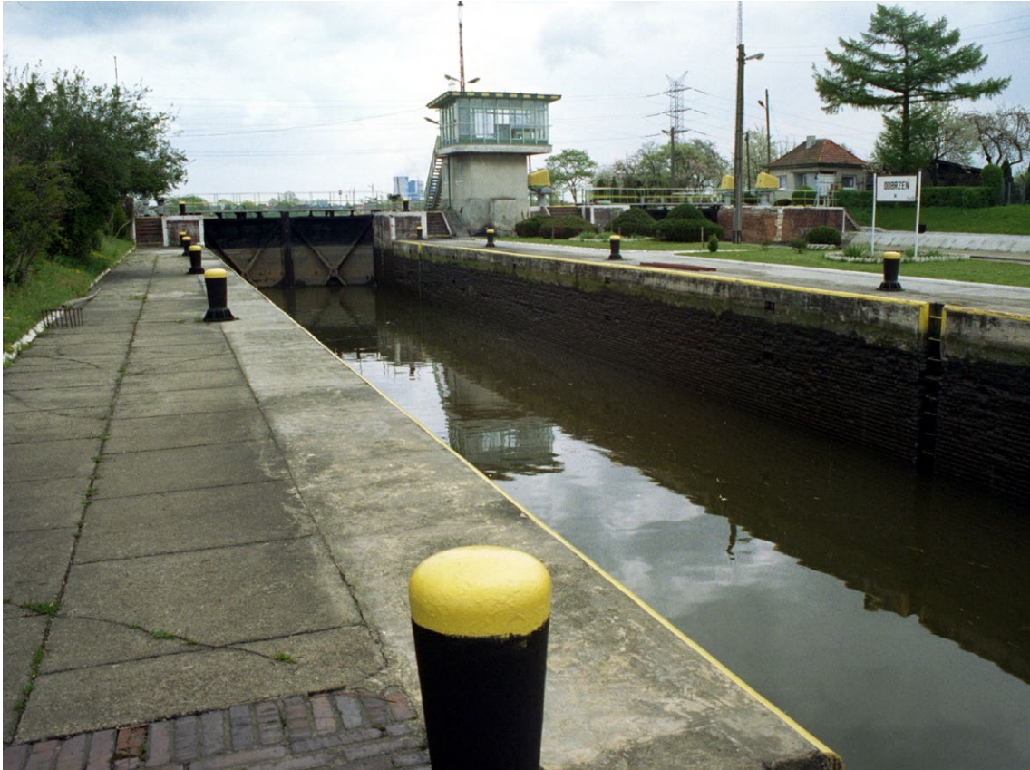
Komora śluzy małej od dolnej wody.
