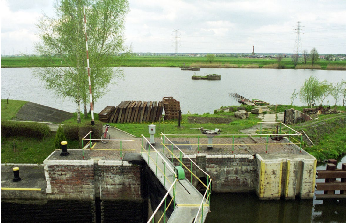
Widok przez głowę dolną śluzy małej na nieczynny jaz kozłowo-iglicowy.
