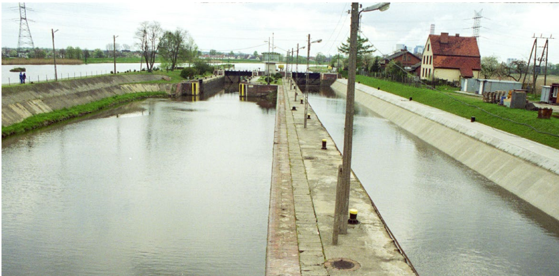
Widok na awanport dolny śluzy małej i komorę śluzy pociągowej.
