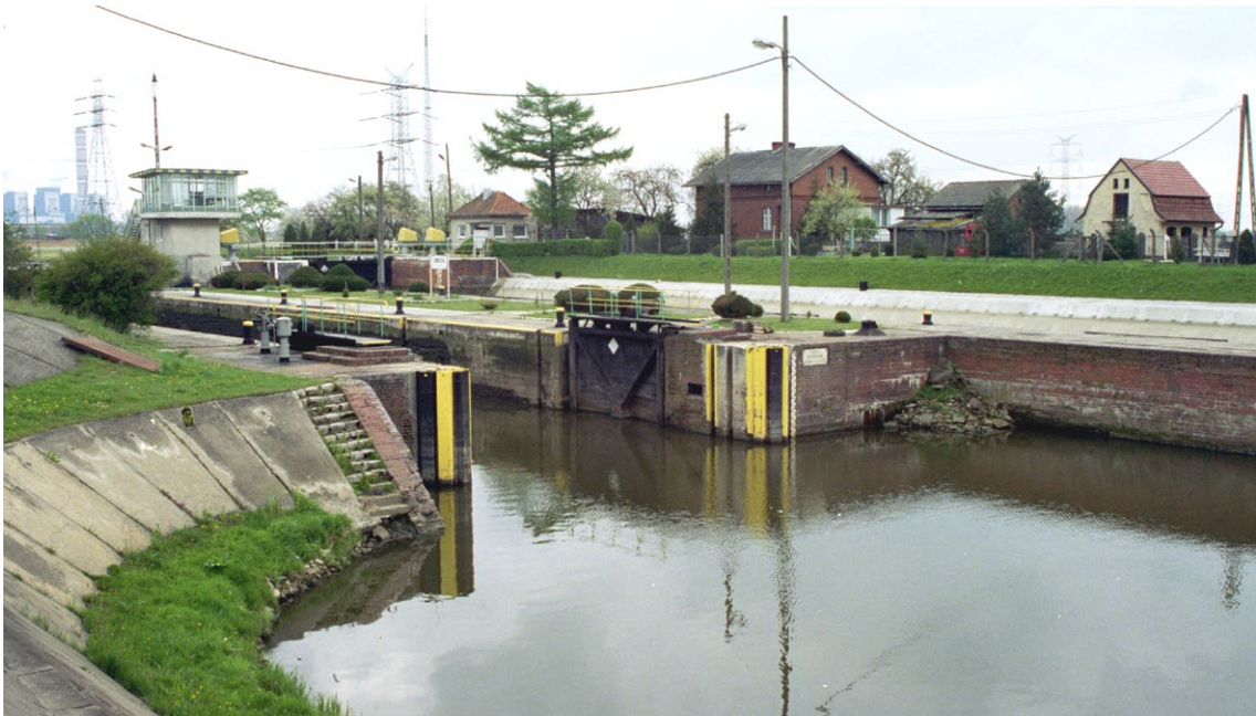
Widok na głowę dolną śluzy małej, wrota górne śluzy dużej, sterownię śluz i zabudowę przystopniową.
