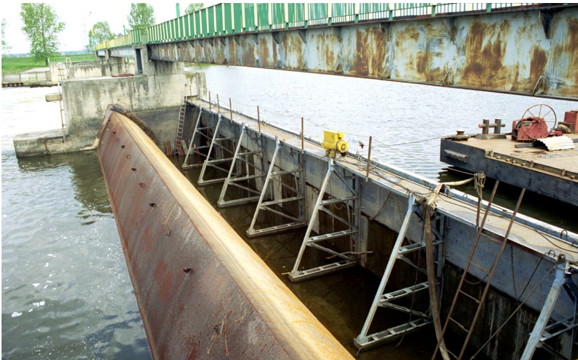
Jaz sektorowy Dobrzeń. Prace remontowe sektora lewego. Dobrze widoczne typowe zamknięcie remontowe kozłowo-zastawkowe od górnej wody.
