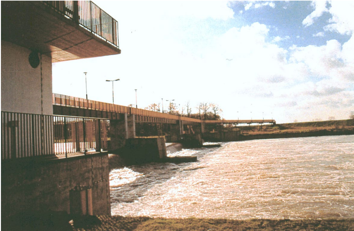
Jaz sektorowy Zawada z kładką komunikacyjną – od dolnej wody.
