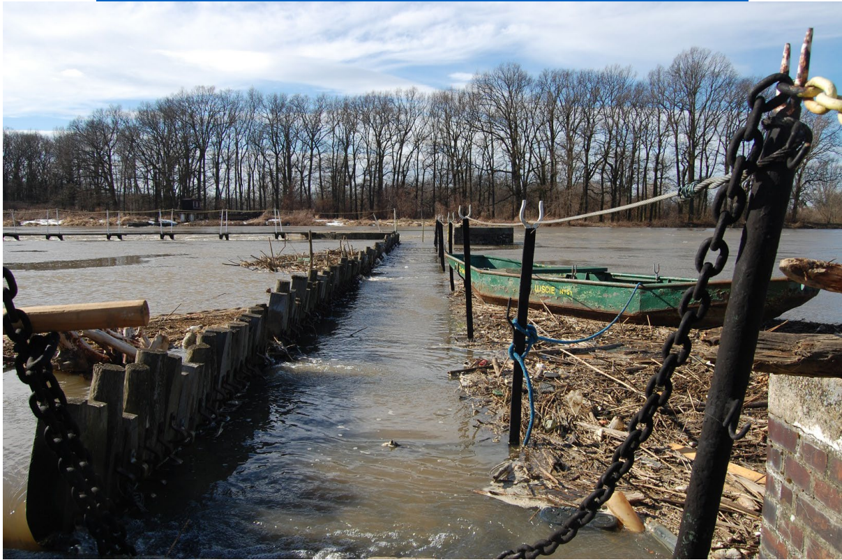
Jaz kozłowo-iglicowy Ujście Nysy podczas przejścia wielkiej wody.
