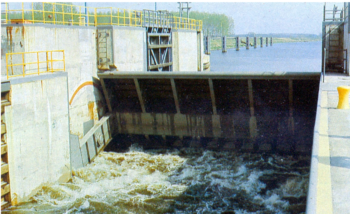
Zamknięcie segmentowe głowy górnej, wrota przeciwpowodziowe i dalbowisko awanportu górnego.
