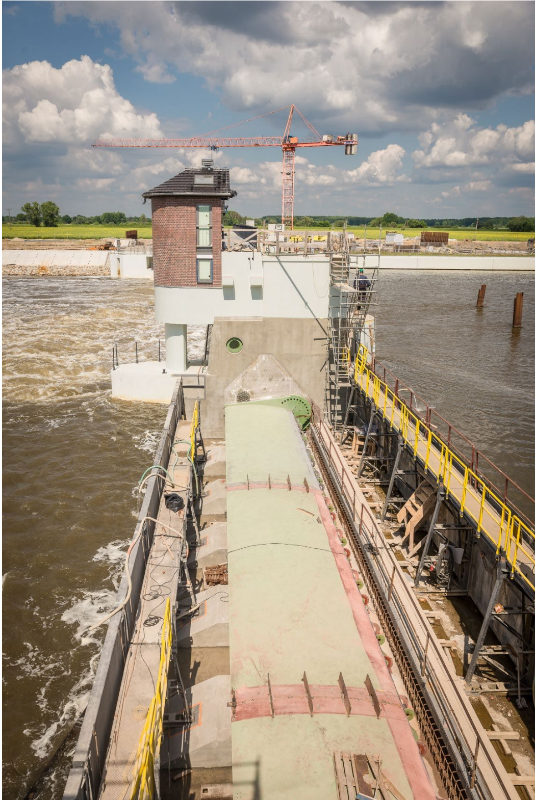
Jaz Zwanowice - przebudowa konstrukcji lewego przęsła z sektorowego na klapowy.
