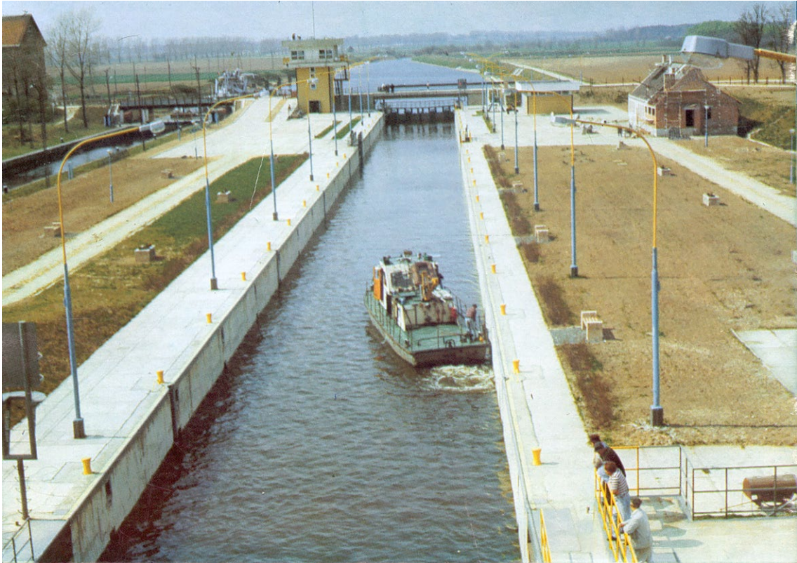
Widok od górnej wody na śluzę dużą nową i pociągową starą, elektrownię wodną i mosty drogowe nad śluzami.
