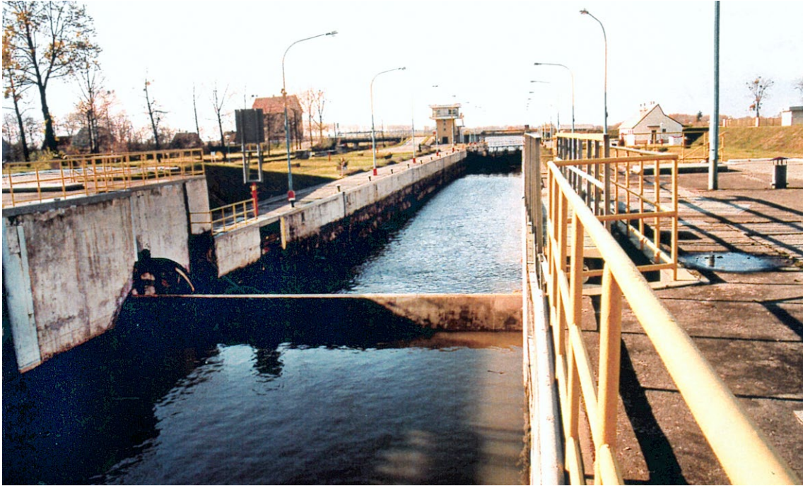
Głowa górna i komora śluzy pociągowej nowej oraz zachowana zabudowa przystopniowa.
