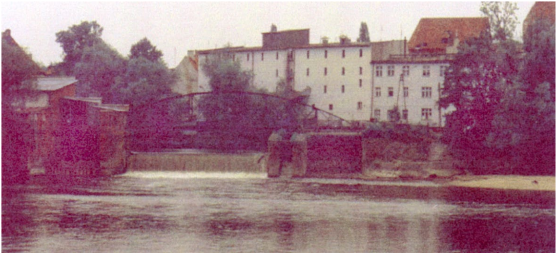
Widok jazu dolnego, przepławki dla ryb, upustu płuczącego od dolnej wody (od północy).
