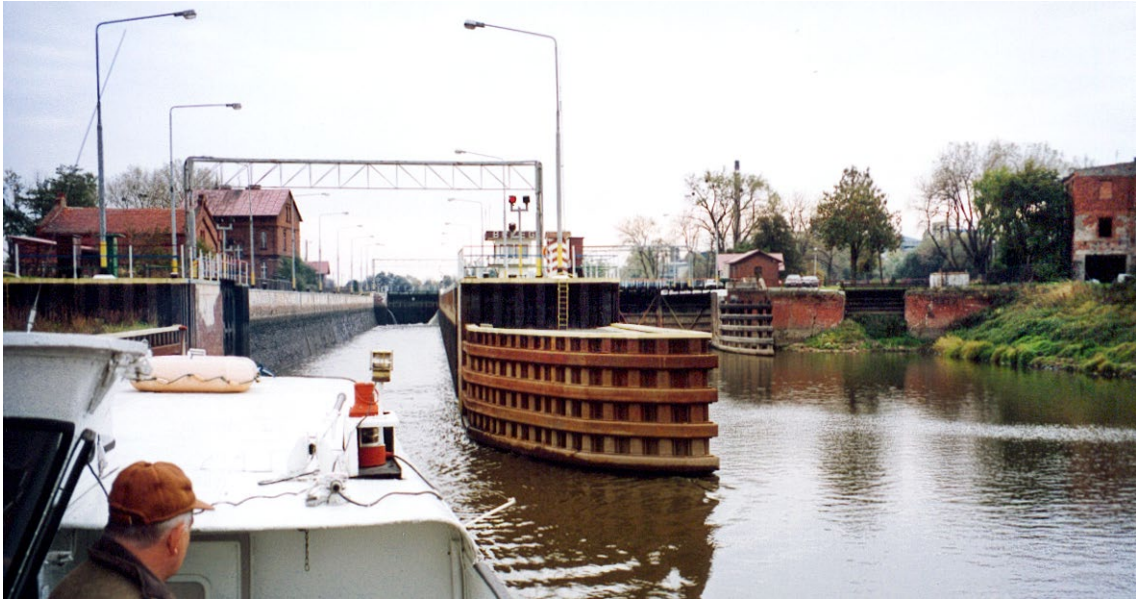
Widok od dolnej wody: komory śluzy dużej (pociągowej), awanportu małej i zasypanej. Także zabudowy przystopniowej i ruin młyna na częściowo zasypanym kanale roboczym. Widok ze statku inspekcyjnego RZGW we Wrocławiu „Kościuszko”.
