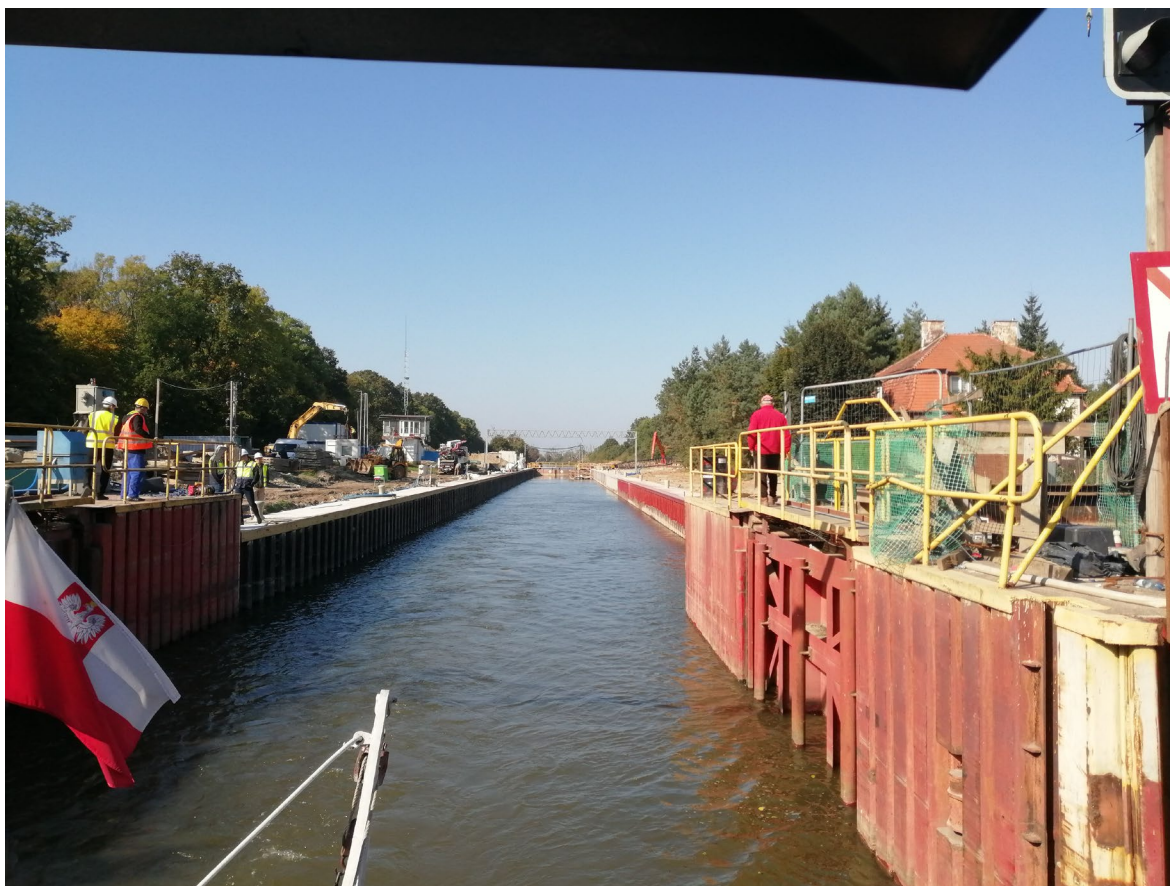
Śluza pociągowa Ratowice – widok na wrota górne, komorę śluzy i wrota dolne od wody górnej.
