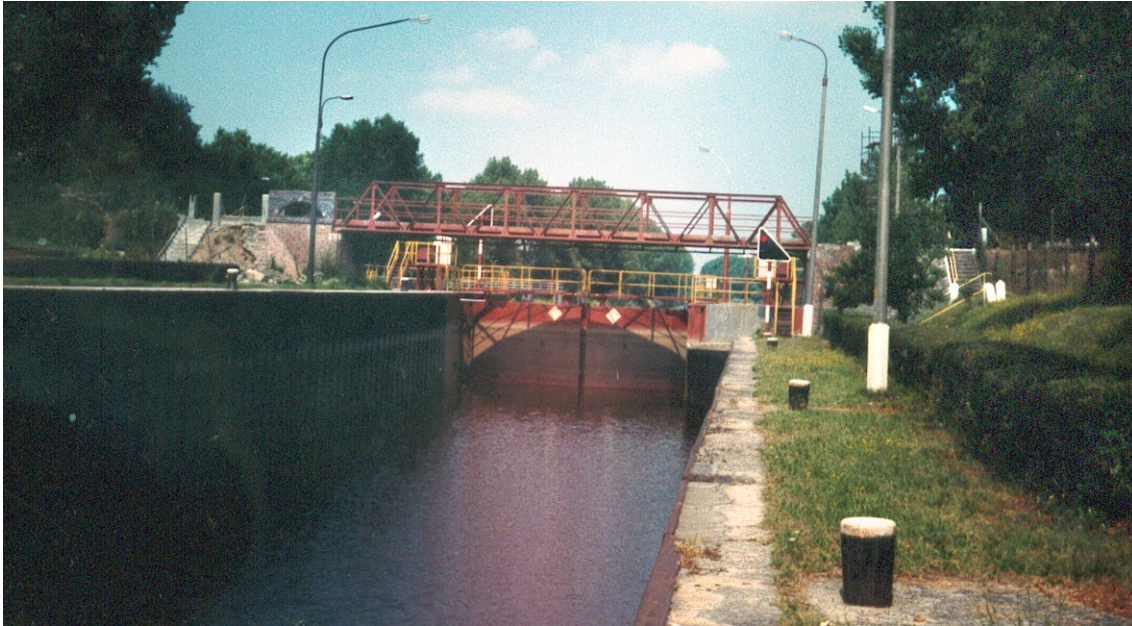
Śluza pociągowa Ratowice – widok na wrota i most nad głową dolną od wody górnej (w czasie remontu ściany lewej).
