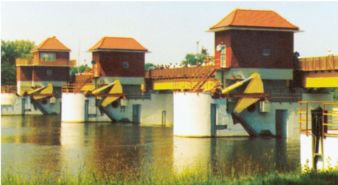
Jaz klapowy w Ratowicach z przepławką dla ryb od górnej wody.
