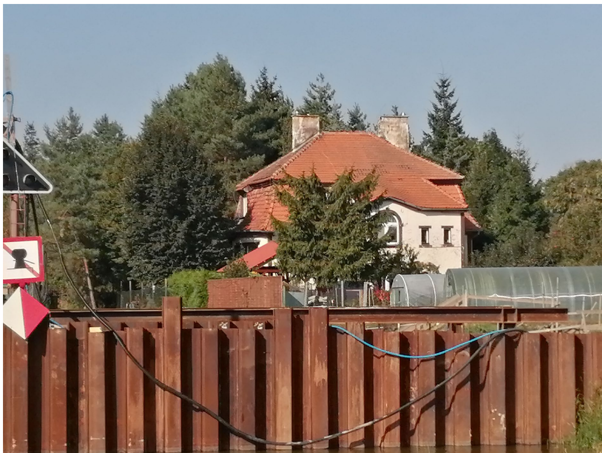
Dom śluzowego po remoncie.
