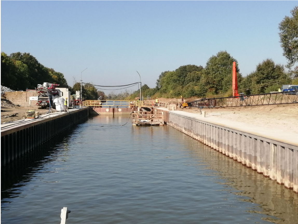
Śluza pociągowa Ratowice – widok na wrota dolne od wody górnej (tuż po remoncie ściany prawej) po zdemontowaniu oryginalnego mostu nad głową dolną podczas remontu i przebudowy śluzy wraz z jej dostosowaniem do min. IV klasy Odrzańskiej Drogi Wodnej.
