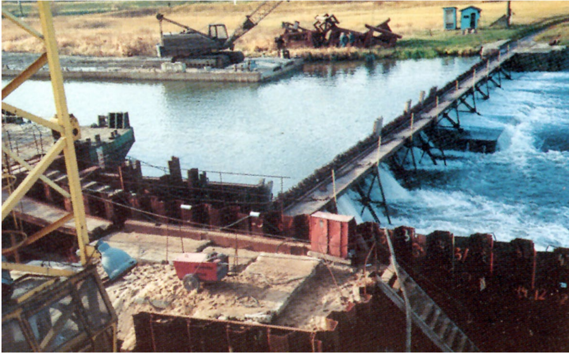
Budowa przęsa środkowego i piętrząca część lewego przęsa jazu dotychczasowego.
