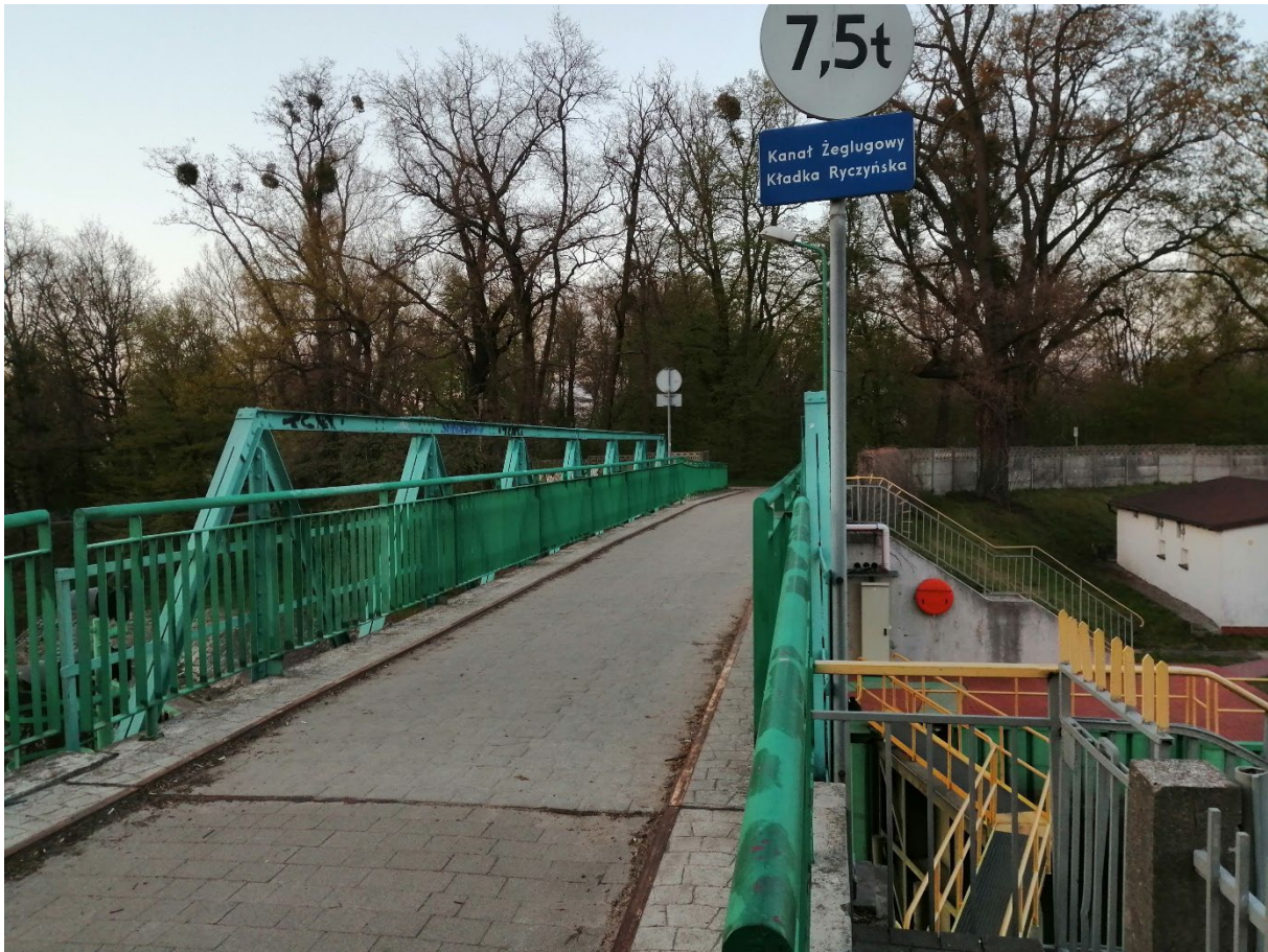
Kładka Ryczyńska nad dolną głową śluzy – widok z prawego brzegu kanału żeglugowego. Pod kładką – kładki robocze na wrotach dolnych śluzy.
