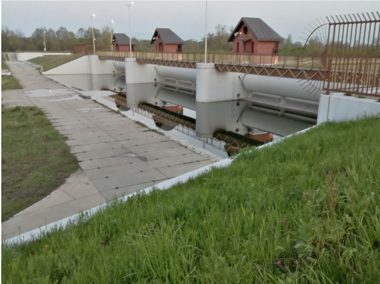
3 przęsła klapowe części ruchomej jazu przepustowego wód z Odry do Widawy z roboczą kładką komunikacyjną. Widok od wody dolnej z brzegu lewego kanału Odplywowego.
