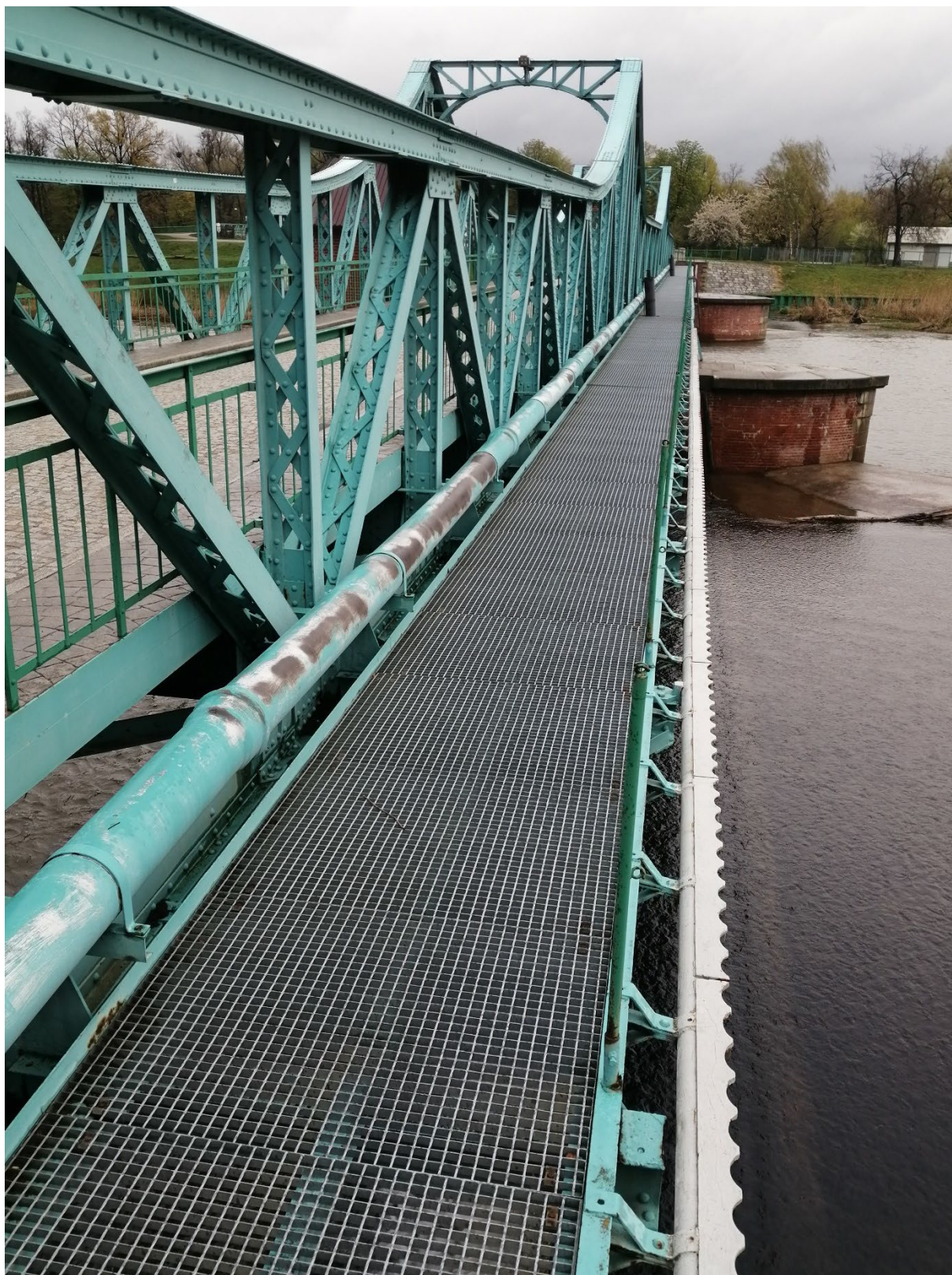
Stała robocza kładka komunikacyjna posadowiona na przyczółkach i filarach mostu jazowego po stronie wody górnej, z zamontowanym tzw. „grzebieniem” dla równego zakładania iglic nowego typu (zamiast drewnianych - stalowe rurowe) – widok z brzegu lewego kanału powodziowego.
