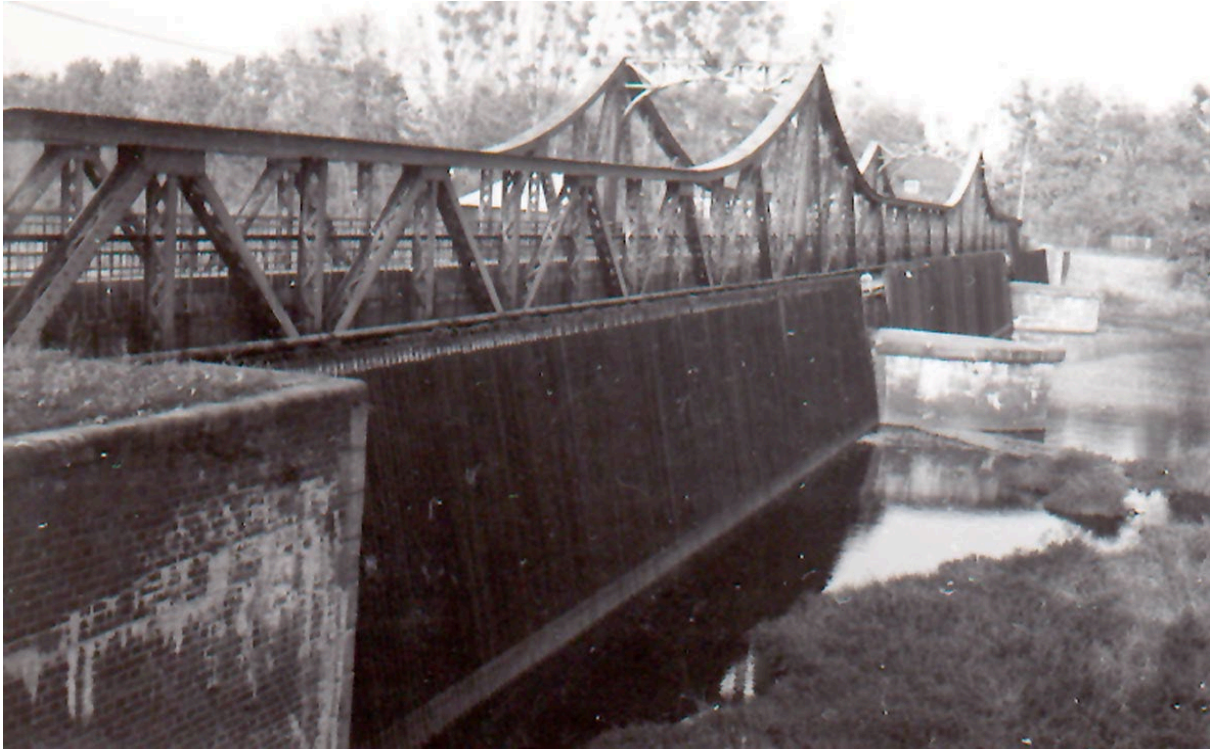
Jaz Bartoszowice z kompletnym zamknięciem iglicowym nowego typu od wody górnej – widok z brzegu lewego kanału powodziowego.
