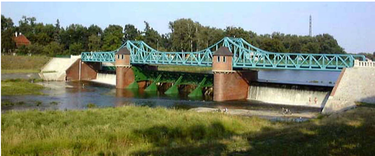
Jaz Bartoszowice z zamknięciem segmentowym widok od dolnej wody; nad jazem – most jazowy.
