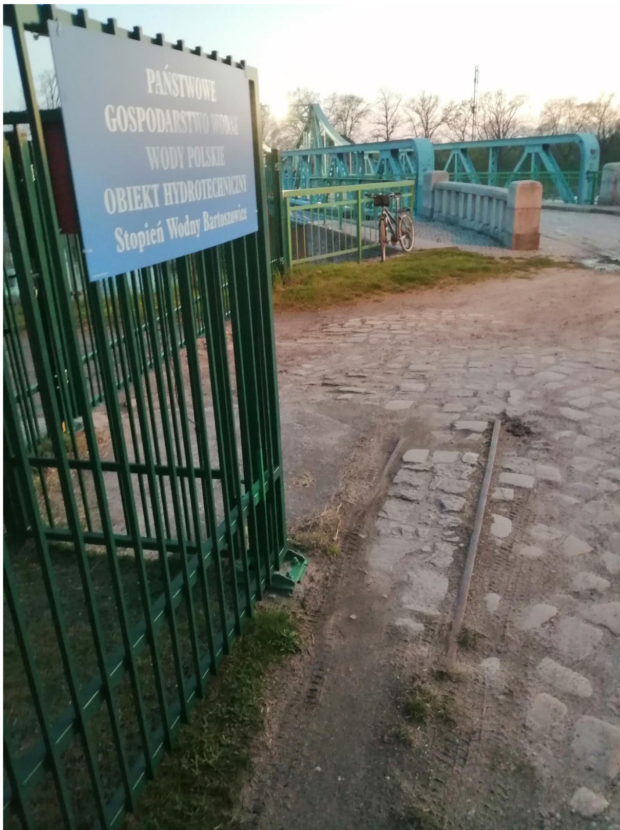
Relikt torowiska dla wózków do przewożenia iglic z magazynu iglic na pomost (i odwrotnie) – widok z brzegu lewego kanału powodziowego.
