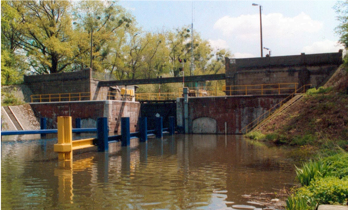
Śluza Bartoszowice – widok od dolnej wody na głowę dolną z przelewu nadmiaru wód z kanału żeglugowego do powodziowego – przed odbudową kładki.
