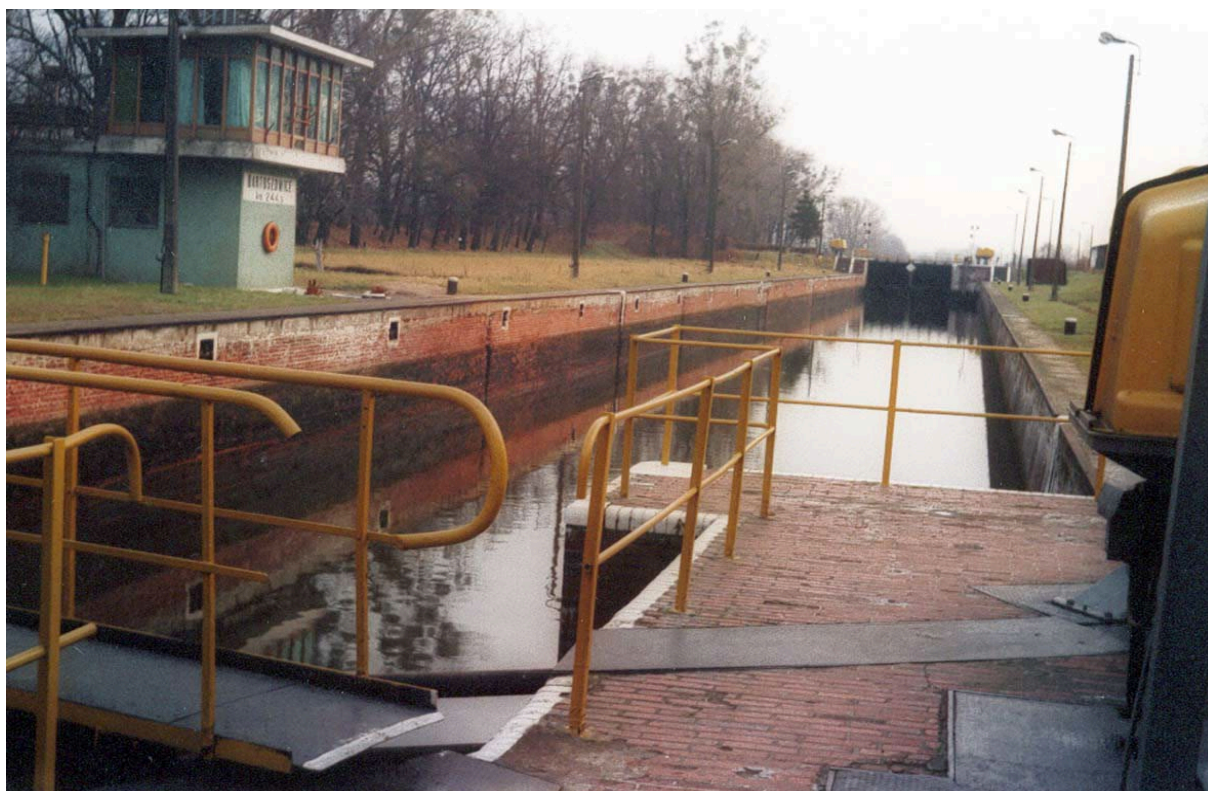
Śluza Bartoszowice – widok od dolnej głowy na górne wrota żeglugowo-powodziowe.
