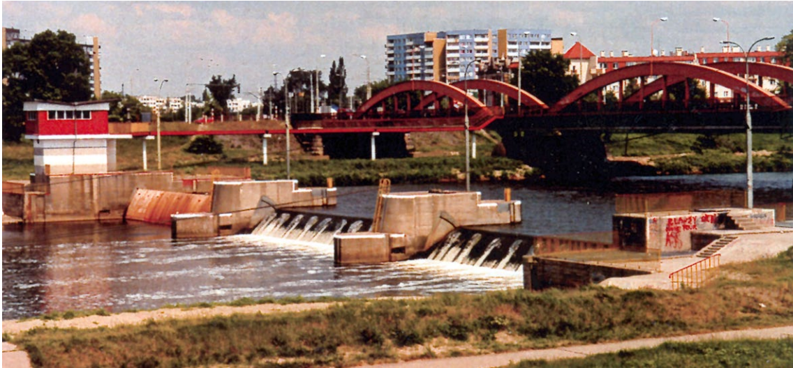
Jaz sektorowy Różanka z wyniesioną ponad poziom wielkiej wody: sterownią jazu i kładką roboczą – widok z brzegu lewego od dolnej wody. Na pierwszym planie komora przepławki, na dalszym planie - most Trzebnicki i osiedle Różanka.
