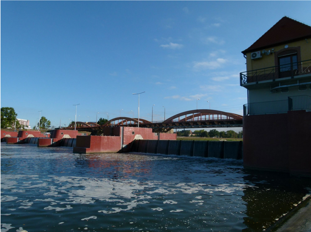
Jaz kłapowy Różanka 2019 r. – widok z brzegu lewego od dolnej wody. Na pierwszym planie budynek zmodernizowanej sterowni w nowej lokalizacji.
