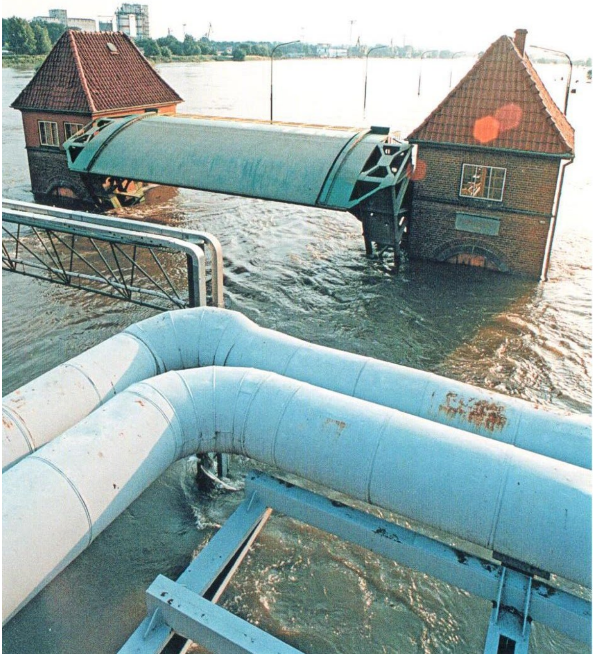
Głowa górna śluzy Różanka z zamknięciem segmentowym, mechanizmem obrotu i budynkiem maszynowni podczas przejścia kulminacji fali powodziowej w lipcu 1997 r. - widok z mostu Osobowickiego. Fot.: Jacek Braun.
