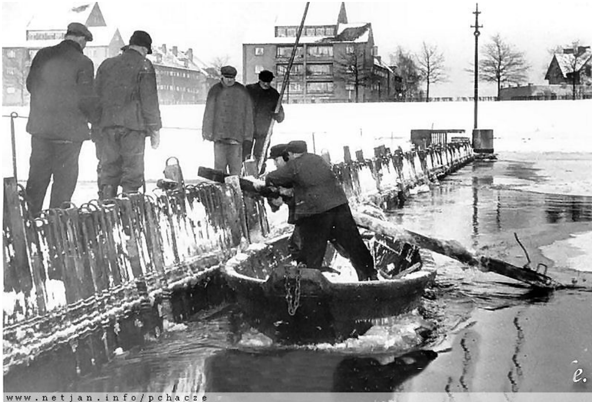
Jaz kozłowo iglicowy w czasie rozigliczania w trudnych warunkach zimowych. Lata 1955-1960. Autor: kmdr Mieczysław Wróblewski. Źródło: https://polska-org.pl/626336,foto.html?idEntity=511798 (Archiwum fotograficzne Janusza Fąfary)
