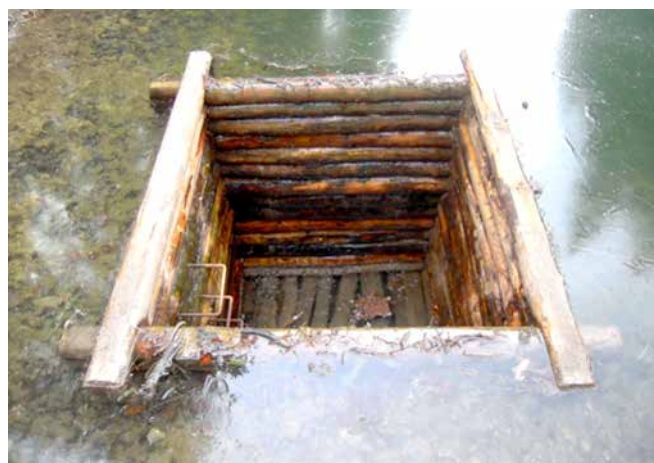
Drewniana, piętrząca studnia przelewowa, foto Ryszard Majewicz
