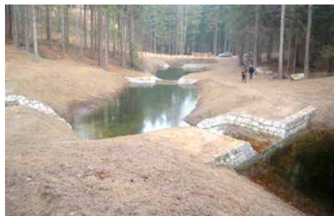
Odtworzony system kaskadowych zbiorników w zlewni kilku potoków, foto Ryszard
