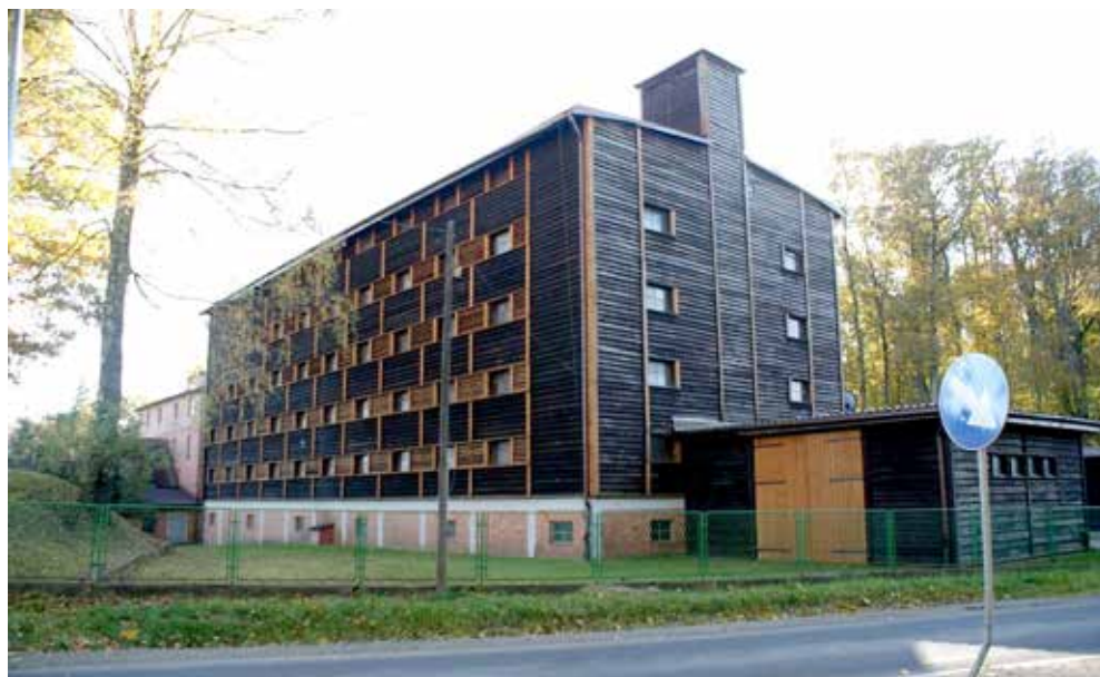
Budynek produkcyjny wyłuszcarni nasion w Rucianem - Nidzie, 1892.
