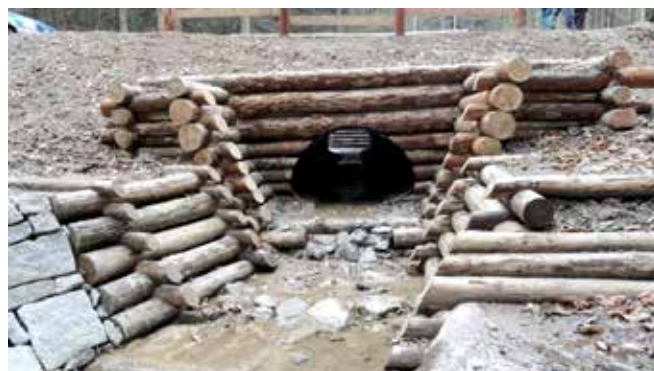
Przepust łukowy pod groblą (obudowany kaszycą), foto Ryszard Majewicz
