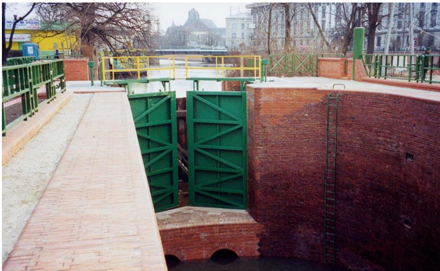
Śluza Mieszkańska – widok górnej głowy z brzegu prawego w końcówce remontu, zablokowana jeszcze stalowym zamknięciem remontowym od wody górnej. Fot.: Ryszard Majewicz.
