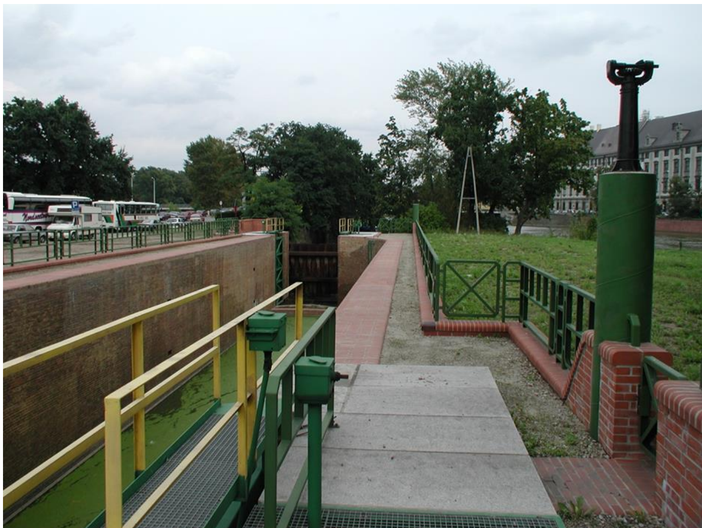
Śluza Mieszcząńska – widok komory śluzy oraz górnej głowy z brzegu lewego w końcówce remontu. Przy otwartych wrotach widoczne stalowe zamknięcie remontowe od wody górnej. Na pierwszym planie: nowy mechanizm otwierania wrot górnej i kanałów obiegowych, z wyeksponowanym pierwotnym mechanizmem „zębatym”. Fot.: Ryszard Majewicz.
