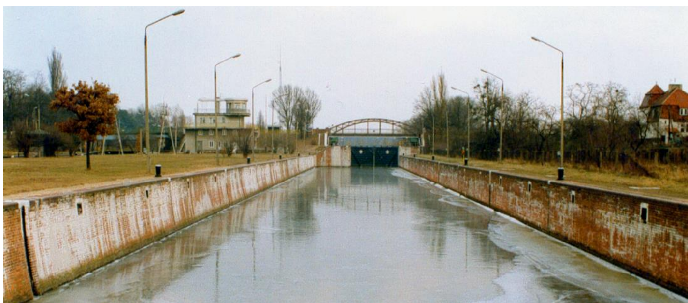
Komora śluzy ceglanej. Widok na głowę górną, most nad śluzą i sterownię od dolnej wody (przed modernizacją).
