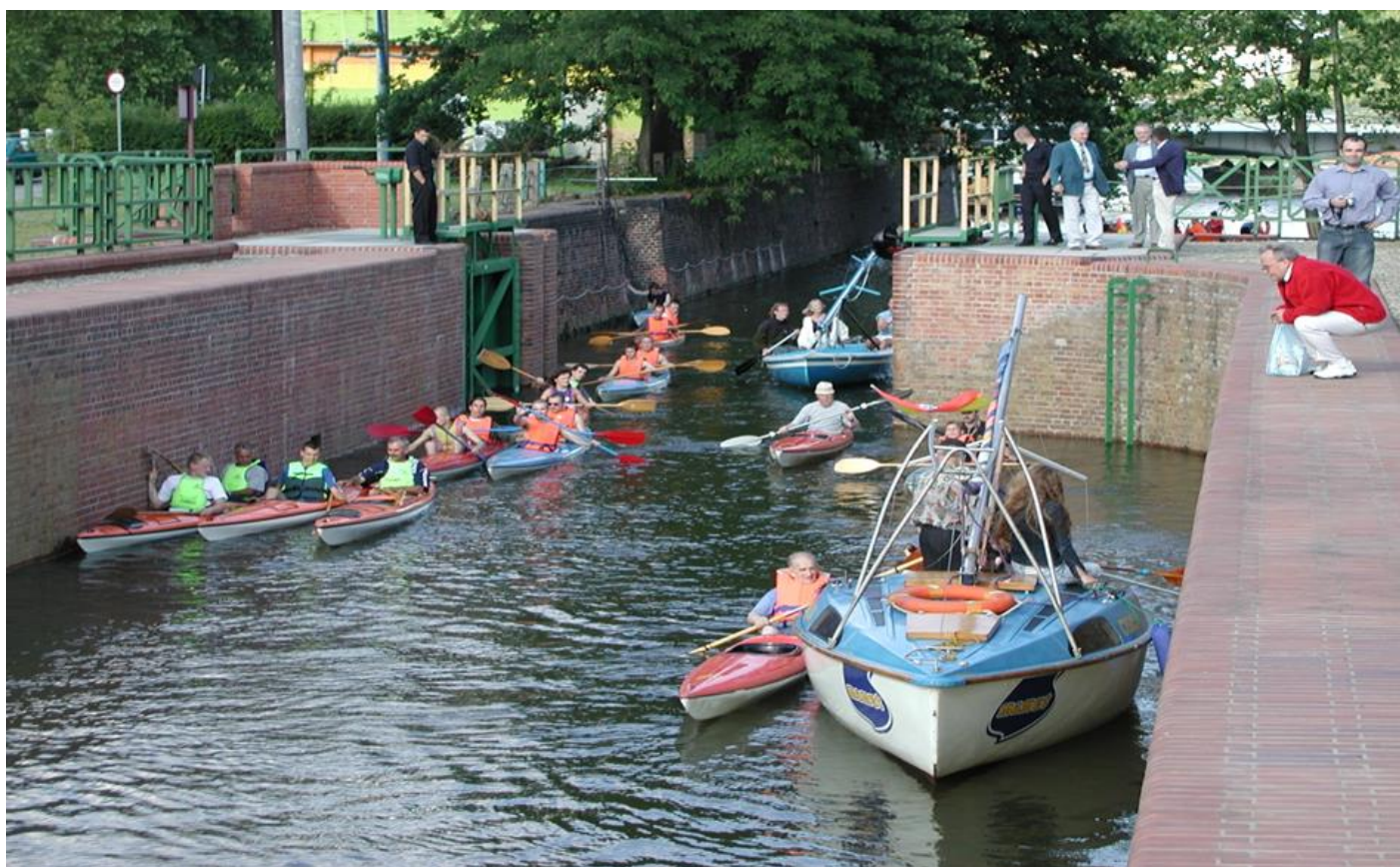
Śluza Mieszkańska po remoncie kapitalnym – powitanie UE na wodach Wrocławia. Fot.: Stanisław Januszewski.
