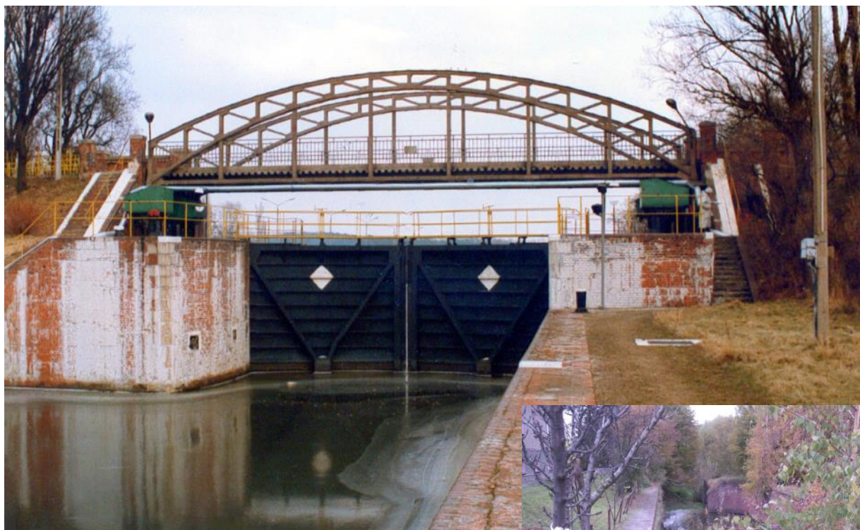
Głowa górna śluzy ceglanej i most nad nią - widziane z komory śluzy (przed modernizacją).
