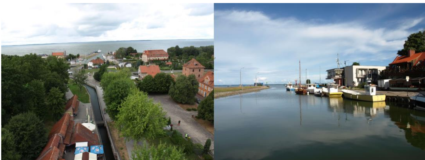
Fot 2. Widok z fromborskiej wieży wodnej na końcowy fragment Kanału Kopernika oraz widok z miejsca ujścia Kanału Kopernika do fromborskiego basenu portowego (źródło: archiwum autora)
