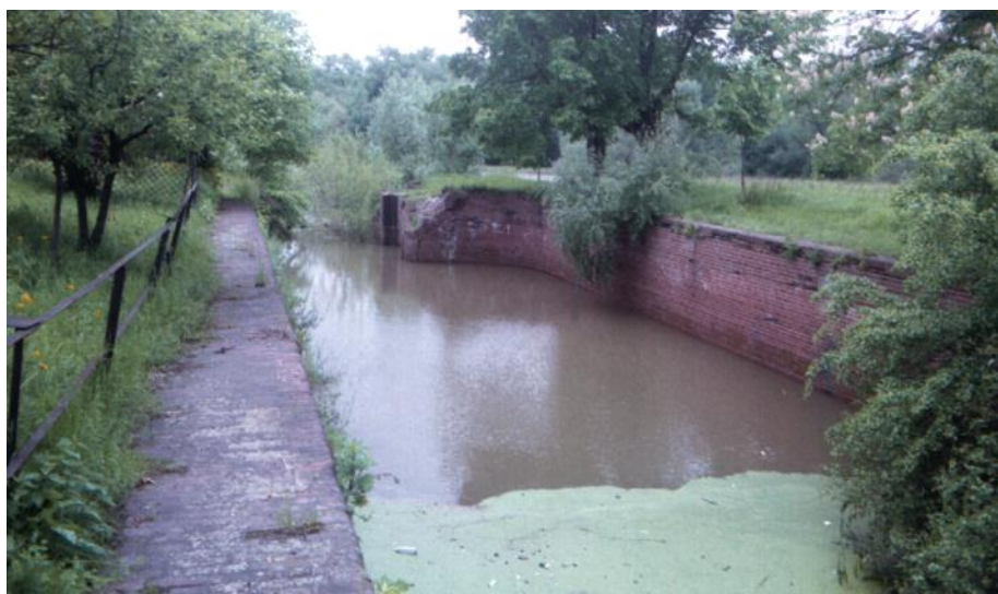
Komora śluzy z przestawionymi głowami w Oławie – widok z brzegu
