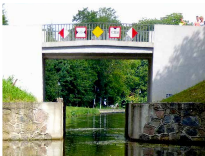
Skrzydło wrót bezpieczeństwa pod mostem w Buczyńcu, foto RZGW w Gdańsku
