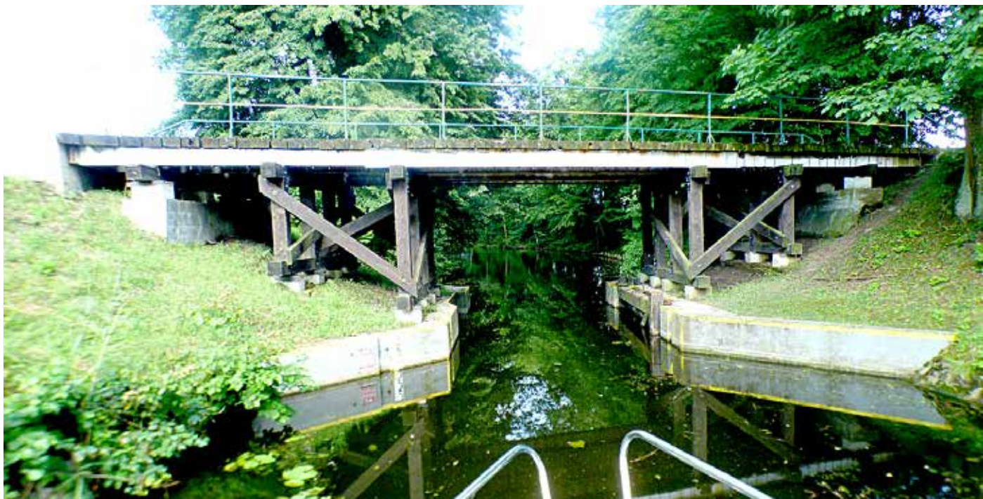
Mozgowo – Zagadka. Wrota ochronne pod mostem drogowym
