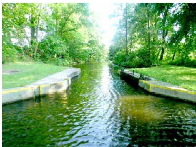
Wrota ochronne, przeciwprzeciwpowodziowe Ligowo na kanale łączącym Miłomłyn z Iławą
