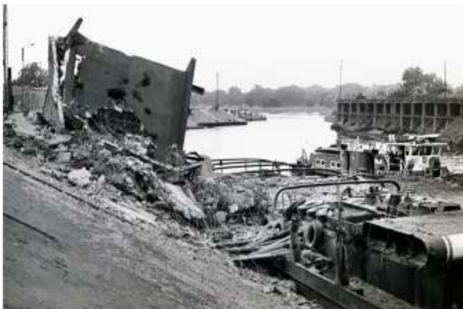
Fragmenty wysadzonej konstrukcji na nabrzeżu i pokładzie „Radgosta”.
