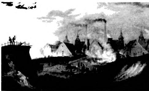
Huta Królewska z północnego zachodu, widok tylny zespołu wielkich pieców z placem koksu i piecem koksowniczym, wjazd pociągu kolejowej z pola zachodniego Kopalni Król, litografia, oryg. Verlag bei Rieden und Knippel in Schmiedeberg, ok. 1845 r.
