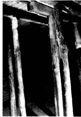
Podstemplowany strop piwnicy z widoczną białą grzybnią Serpula lacry- mans, oficyna poprzeczna przy ul. Stalowej 73 (zdj. M. Wesołowska, 2019)
