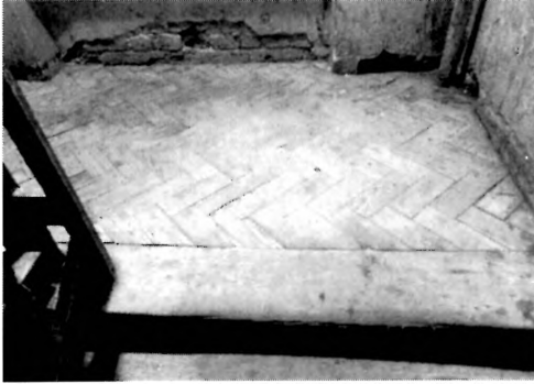
Posadzka spocznika w formie jodełki, kamienica przy ul. Środkowej 11 (zdj. M. Wesołowska, 2021)
