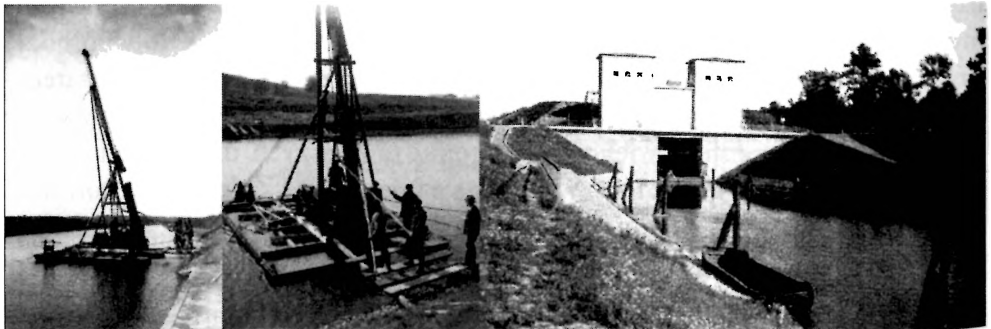
Wbijanie pali przy słuzie Sandhof/Piaski przez pracowników firmy Philipp Holzmann oraz widok niemalże ukończonej słuzi Georgenfelde/Ozierki – w 1939 r. (źródło: Deutsche Digitale Bibliothek oraz archiwum autora)
