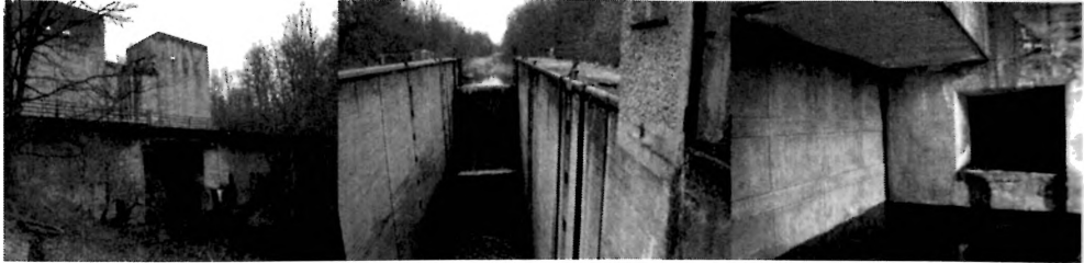
Widok mostu drogowego i głowy dolnej, wnętrza komory śluzowej oraz wrót głowy dolnej śluzy Georgenfelde/Ozierki (autor: C. Wawrzyński)
