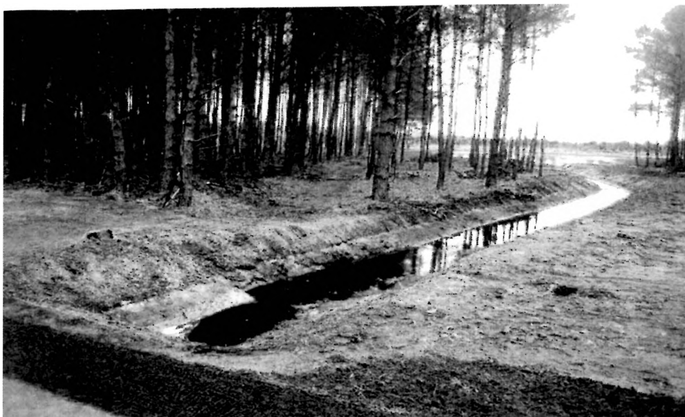
Odtworzony system melioracyjny w Borach Dolnośląskich, nawadniający zdegradowane tereny popoligonowe (wcześniej wylesione) w Nadleśnictwie Świątoszów
