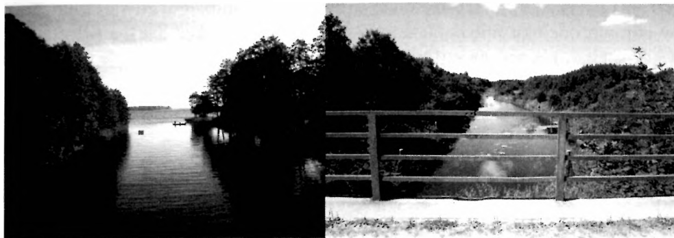
Widok z mostu drogowego na początek Kanału Mazurskiego od strony polskiej (styk z jeziorem Mamry) oraz widok z mostu i głowy dolnej śluzy Sandhof/Piaski w kierunku północno-zachodnim (autor: C. Wawrzyński)
