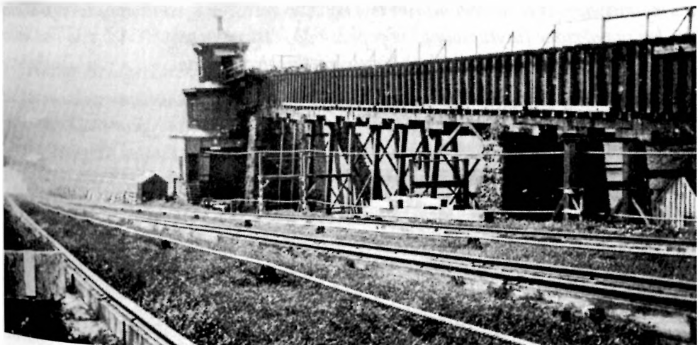
Siłownia na pochylni nr 9 West po przebudowie. Źródło: www.njtpa.org
