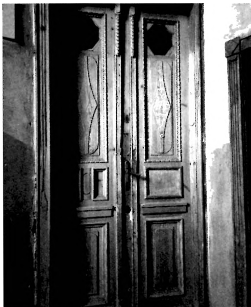
Stolarka drzwiowa głównej klatki schodowej, kamienica przy ul. Środkowej 11 (zdj. M. Wesołowska, 2021)
