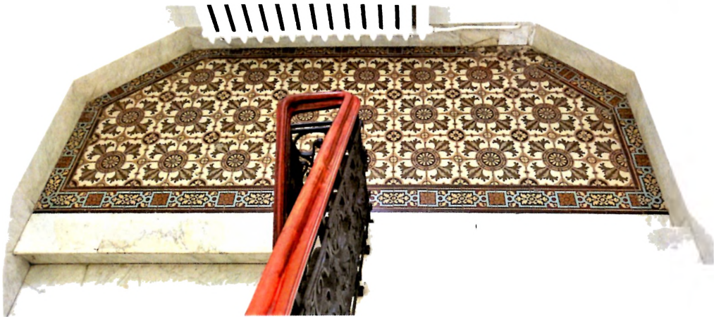
Podest półpiętra głównej klatki schodowej, fot. K. Komar-Michalczyk, 2021
