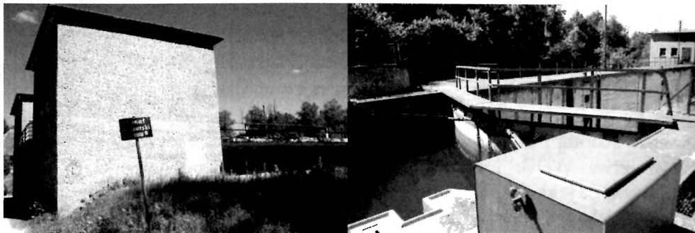
Jedyna ukończona budowla – śluza Sandhof/Piaski na Kanale Mazurskim (autor: C. Wawrzyński)
