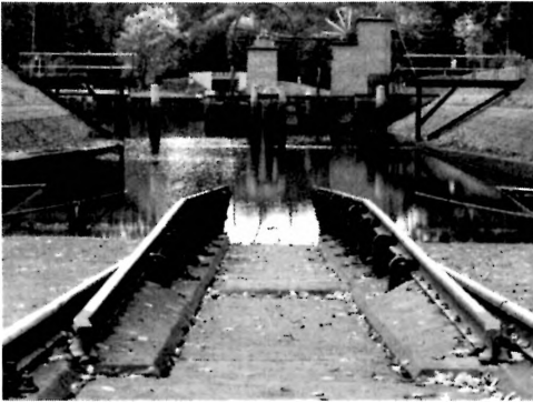
Szyny różnicowe na górnym stanowisku pochylni Buczyniec. Widok po odwodnieniu pochylni w dniu 17 października 2020 r. Fot. R. Kowalski. Według Georga J. Steenkego ( Eine geneigte Ebene... , 1865): „Amerykanie stosują wozy drewniane i nie znają szyn różnicowych.
