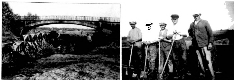
Prace ziemne na Kanale Mazurskim w drugiej połowie lat 30. XX w. (źródło: Bildarchiv Ostpreußen)
