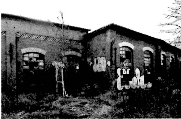
Elewacje obwodowe – oryginalna z 1909 roku i dobudowanej nawy niższej
