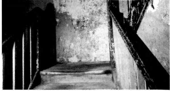
Drewniane schody, oficyna poprzeczna przy ul. Stalowej 73 (zdj. M. Wesołowska, 2019)
