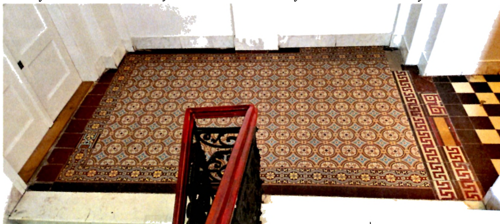
Płytki typowe podestu piętra głównej klatki schodowej; z prawej strony widoczne uzupełnienia ubytków, m.in. płytkami z motywem meandra, oraz fragment z zapewne powojennymi płytkami w kolorach czarnym i białym ułożonymi w szachownicę
