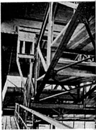
Abb. 22. Untersuchungswagen: Blick von Süden auf Wagen, Aufhängung und Lagerung der Laufbrücke.
