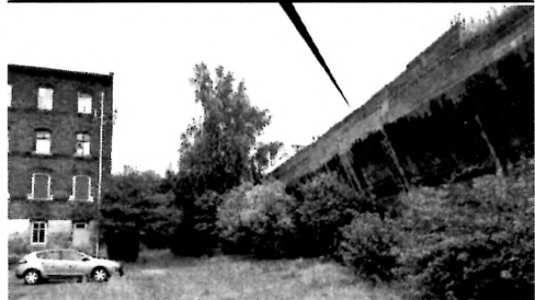
Mur oporowy – jego kształt wynika z braku miejsca na nasyp oraz z niestabilności gruntu, foto: Dobromir Kaźmierczak
