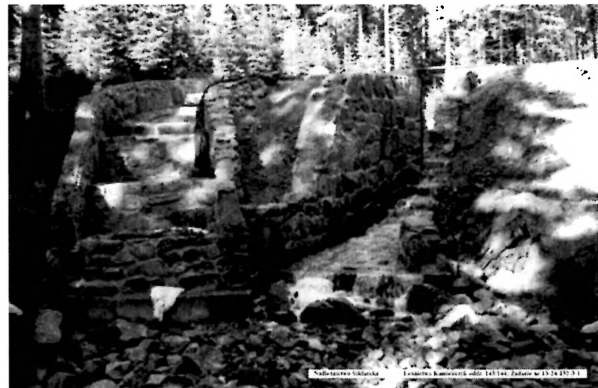
Odbudowany zbiornik retencyjny, służący do splawu drewna, położony w Karkonoszach, w Nadleśnictwie Szklarska Poręba
