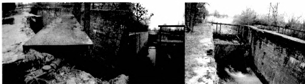
Widok komory śluzy Allenburg I/Družba I. Dwuskrzydłowe wrota od strony głowy dolnej i Łyny (autor: C. Warwzyński)
