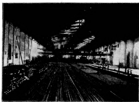
Hala walcowni w hucie w Borku Fałęckim
