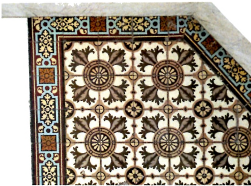
Płytki podestu półpiętra głównej klatki schodowej, fot. K. Komar-Michalczyk, 2021
