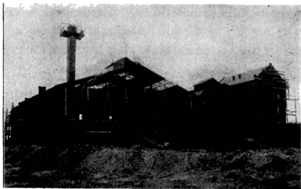
Elektrownia okręgowa w „Sierszy” w budowie
