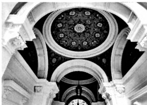
Sklepienie przejazdu bramnego kamienicy przy ul. Szpitalnej 8 w Warszawie, fot. K. Komar-Michalczyk, 2021
