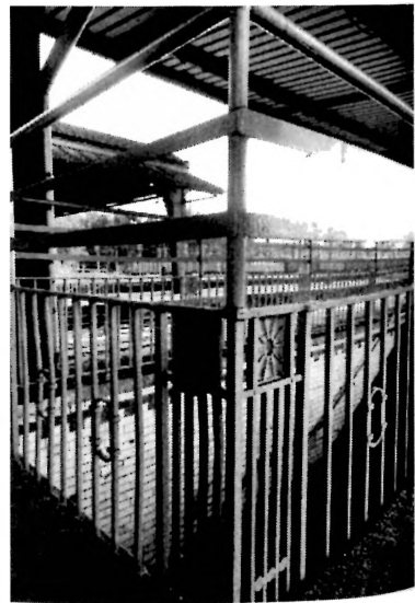
Balustrada zejścia z peronu 1. do tunelu. Pozostałość po wcześniejszym dworcu, foto: Dobromir Kaźmierczak
