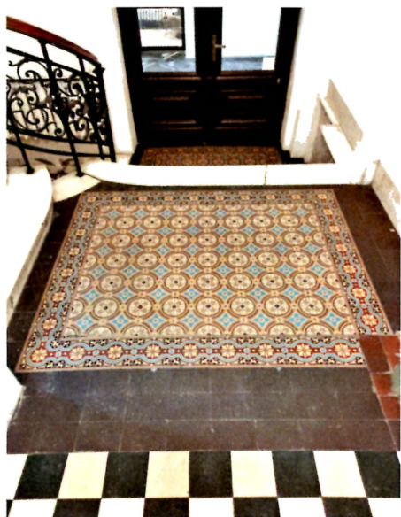
Podest za biegiem wyrównawczym schodów główniej klatki schodowej, fot. K. Komar-Michalczyk, 2021
