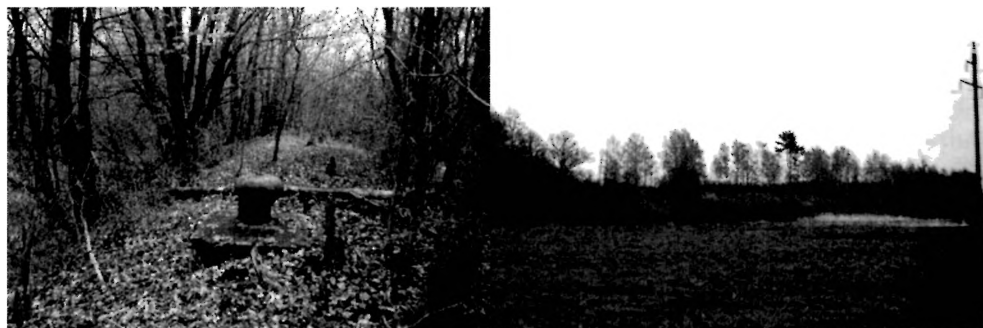
Poler cumowniczy przy podejściu do służy Allenburg II/Družba II oraz wały kanałowe przy służy Gross Allendorf/Kostromino (autor: C. Wawrzyński)
