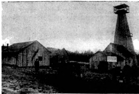
Głębokie wiercenia wykonywane dla huty cynku w Trzebini
