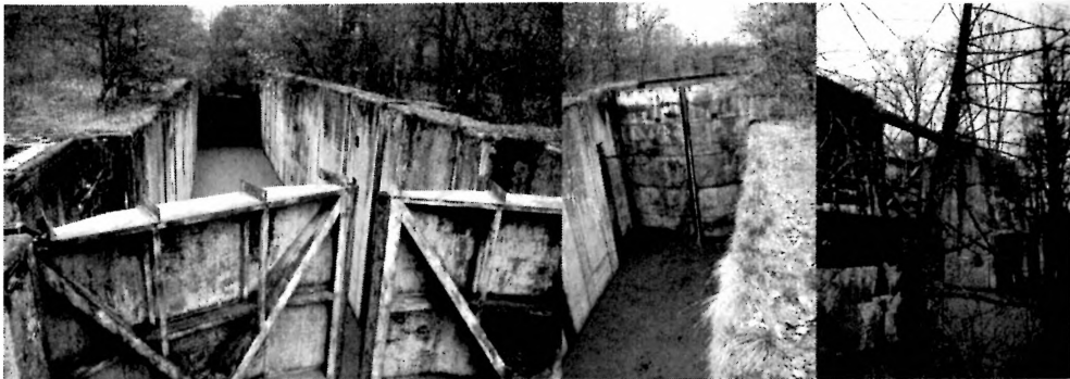
Widok komory i głowy dolnej śluzy Allenburg II/Družba II . Dwuskrzydłowe wrota od strony głowy dolnej (autor: C. Wawrzyński)
