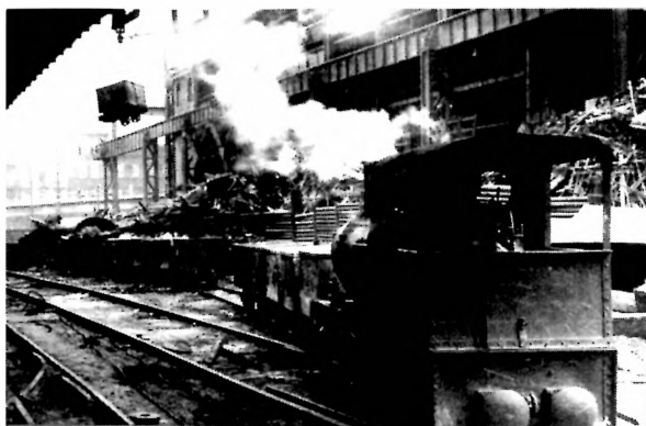
Kolej technologiczna o rozstawie toru 615 mm na terenie Królewskiej Huty, lata 30. XX w., ze zbiorów autora
