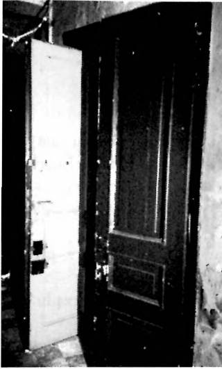
Stolarka drzewiowa, oficyna poprzeczna przy ul. Stalowej 73 (zdj. M. Wesołowska, 2019)
