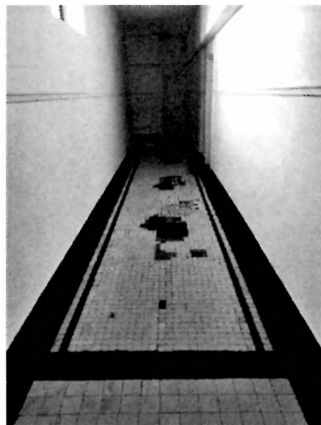
Podest korytarza ostatniej kondygnacji, łączący klatkę schodową ob. nr I i nr II – fragment wzdłuż ulicy Górskiego, widoczne miejsce styku części wyłożonej płytkami o wym. 5 x 5 cm (w górnej części zdjęcia) oraz części wyłożonej płytkami o wym. 10 x 10 cm (u dołu kadru), fot. K. Komar-Michalczyk, 2021
