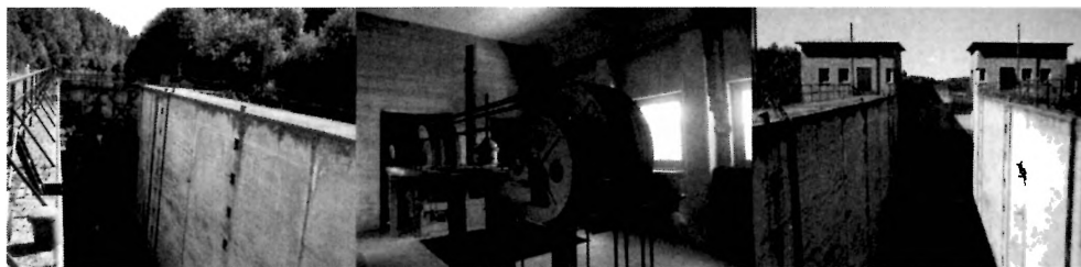
Widok komory śluzowej oraz pozostałości urządzeń w sterówce śluzy Sandhof/Piaski (autor: C. Wawrzyński)
