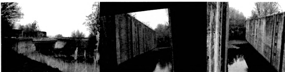
Widok mostu drogowego i głowy dolnej oraz wnętrza komory śluzy Wilhelmshof/Marinowka (autor: C. Warczyński)
