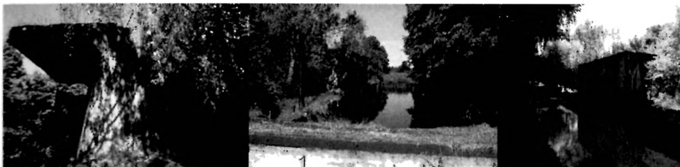
Widok pozostałości początków budowy śluzy Langenfeld/Długopole (autor: C. Warwzyński)
