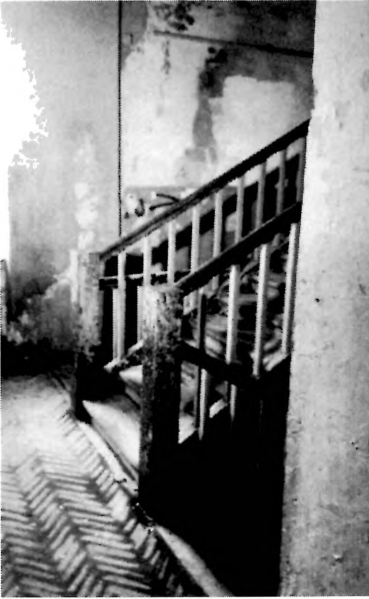
Spocznik z posadzką w formie jodełki, oficyna poprzeczna przy ul. Stalowej 73 (zdj. M. Wesołowska, 2019)
