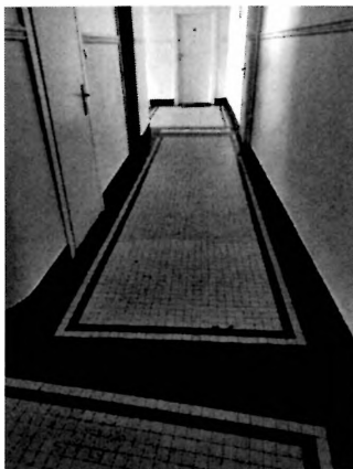
Podest korytarza ostatniej kondygnacji, łączący klatkę schodową ob. nr I i nr II – fragment wzdłuż ulicy Szpitalnej, wyłożony płytkami o wym. 5 x 5 cm, fot. K. Komar-Michalczyk, 2021
