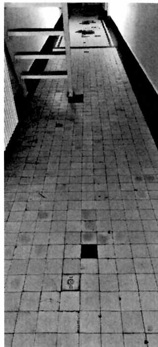
016b. Podest korytarza ostatniej kondygnacji, łączący klatkę schodową ob. nr I i nr II – fragment wzdłuż ulicy Górskiego, wyłożony płytkami o wym. 10 x 10 cm, fot. K. Komar-Michalczyk, 2021
